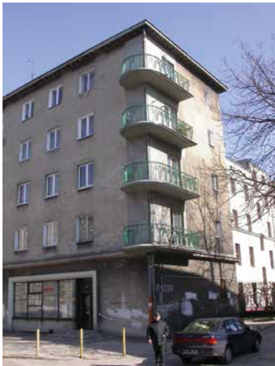
Il. 4. Typowy blok osiedla staromiejskiego, fot. A. Sumorok
