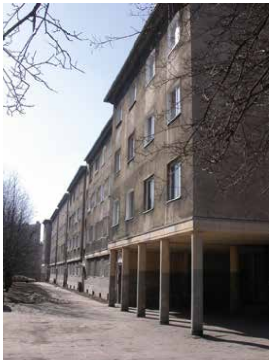
Il. 5. Typowy blok osiedla staromiejskiego, fot. A. Sumorok
