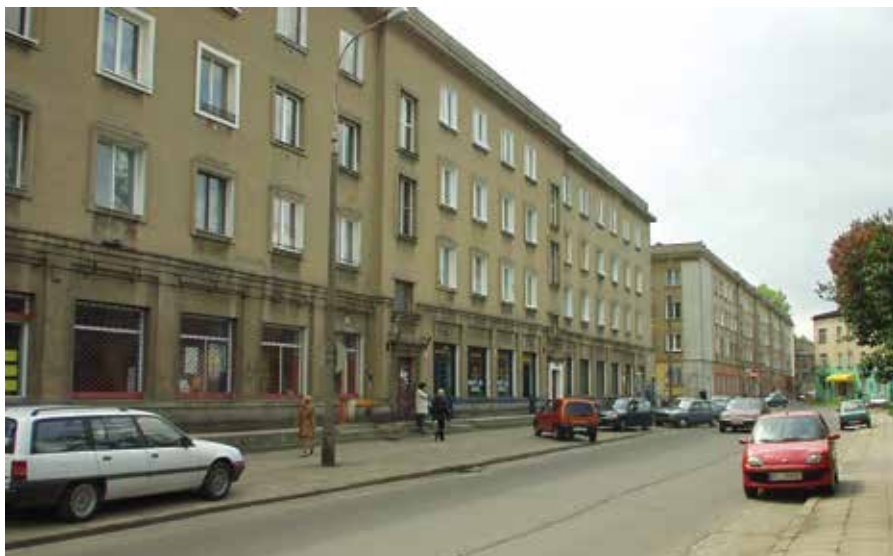
Il. 10. Bloki tworzące ciąg mieszkalno-handlowy, Bałuty I, ul. WIN, fot. A. Sumorok
