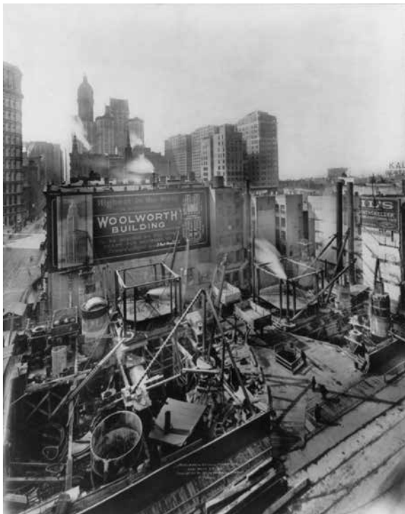
II. 4. Początek budowy Woolworth Building, ok. 1911 (fot. ze zbiorów Biblioteki Kongresu)
