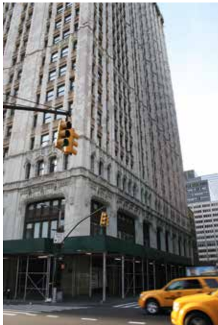
Il. 10. Dolne elewacje w trakcie prac renowacyjnych (fot. Agnieszka Zydorowicz, 2012)
