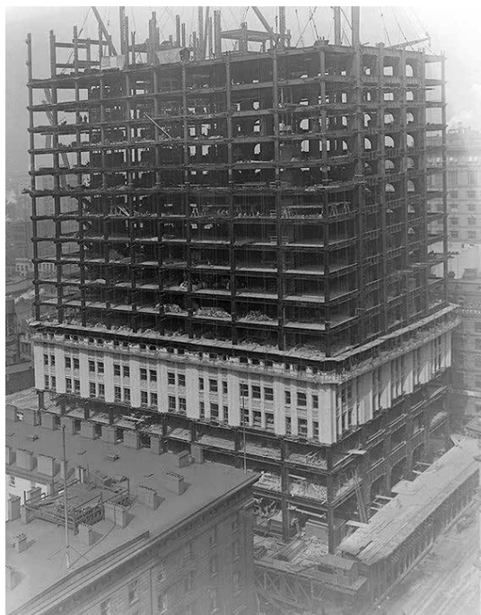
II. 5. Budynek w trakcie prac, ok. 1911 (fot. ze zbiorów Biblioteki Kongresu)
