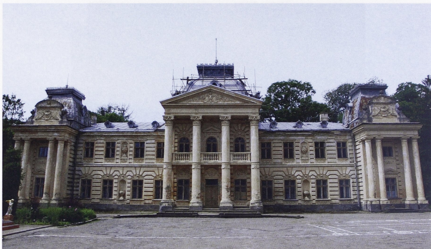
Il. 11. Pałac w Koropcu – widok elewacji frontowej od strony dziedzińca, stan w 2017 r. (fot. J. Kucharzewska, 2017 r.)
