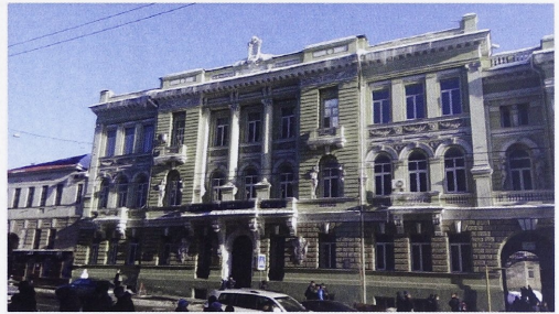
Il. 4. Budynek Rady Zjazdu Przemysłowców Górniczych Południa Rosji, ob. Technikum Radiotechniczne, ul. Sumska 18/20, proj. Bolesław Michałowski (fot. L. Żwanko, 2017 r.)
