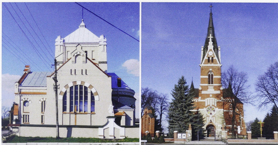
Il. 9. Architektura sakralna (a. fot. B. Kosar, b. źródło: http://static.panoramio.com/photos/original/49311341.jpg )
