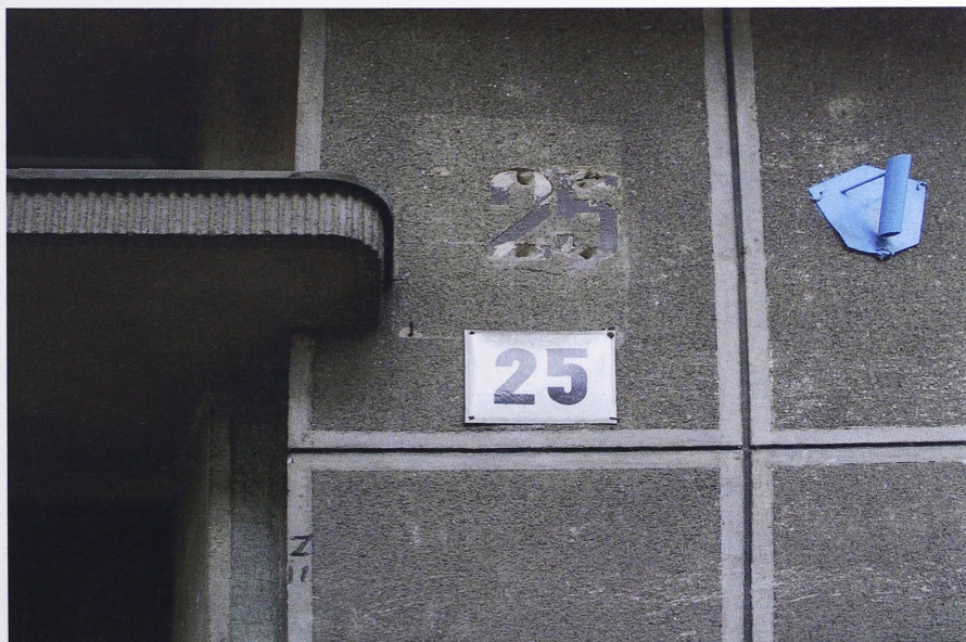
Il. 7. A-B. Budynek przy ul. Kochanowskiego (ob. ul. Kostki Lewickiego) 25/25a, 1937–1938, proj. Ferdynand Kassler (fot. M. Korpała)
