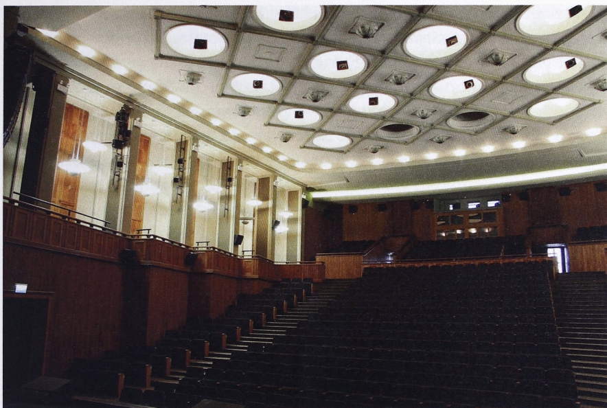
Il. 7. Drewniany strop kasetonowy sali widowiskowej w domu kultury w Ozimku (fot. A. Sumorok)
