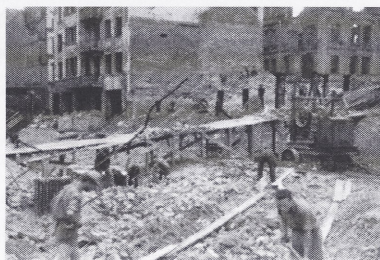
Il. 1. Fotografia z albumu pamiątkowego: „Praca brygady Służby Polsce przy budowie arterii Nadodrzańskiej w Szczecinie 1 V 48–30 X 48, 1 V 49–30 X 49” [pisownia oryginalna], przekazanego przez junaków prezydentowi miasta Szczecina, inż. mgr. Piotrowi Zarembie; w tle kamienice przeznaczone do rozbiórki (z archiwum Katedry Historii i Teorii Architektury ZUT w Szczecinie)
