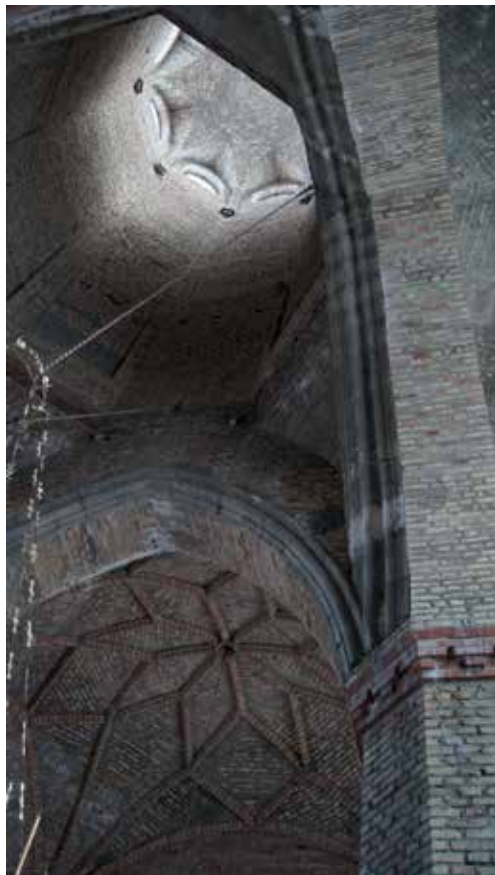
Il. 7. Supraśl. Cerkiew prawosławna (katolikon) Zwiastowania Przenajświętszej Bogurodzicy. Kopała i sklepienie wschodnie po rekonstrukcji. Fot. J. Uścińowicz 2011 r.
