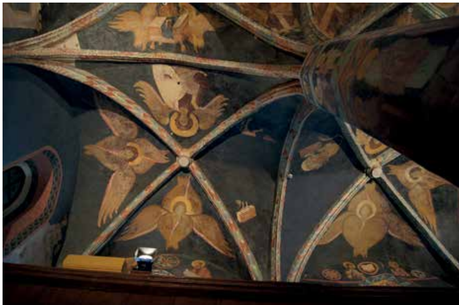
Il. 1. Lublin. Kaplica rzymskokatolicka Trójcy Świętej. Sklepienie nawy. Fot. J. Uściłowicz 2012 r.
