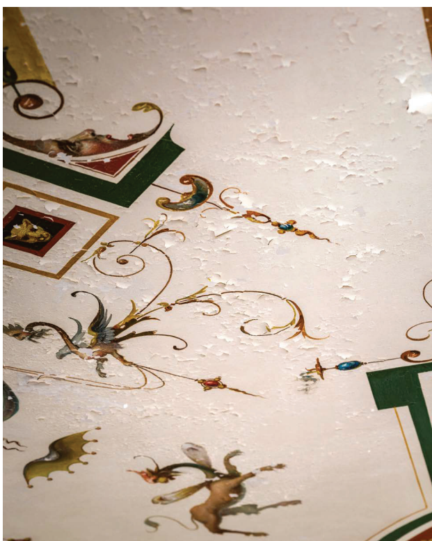
ILL. 5 Dommages constatés sur les grotesques peintes au piano nobile
