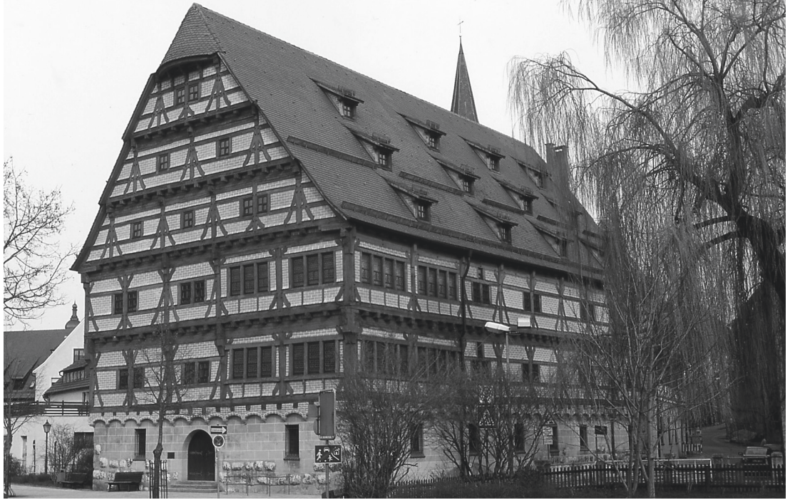
Abb. 13: Ehingen, Spital. Blick auf das 1532 entstandene sog. Neuhaus. Das stattliche Fachwerkgebäude darf als exemplarischer Vertreter eines Pfründnerhauses gelten.
