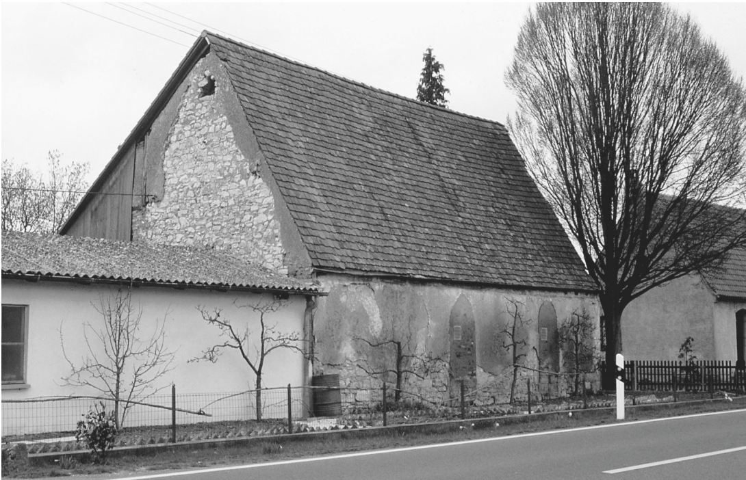
Abb. 14: Riedlingen, ehem. Siechenkapelle. Riedlingen besaß ein außerhalb der Stadtmauern gelegenes Siechenhaus, das zumindest in späterer Zeit unter der Verwaltung des Spitals stand.
