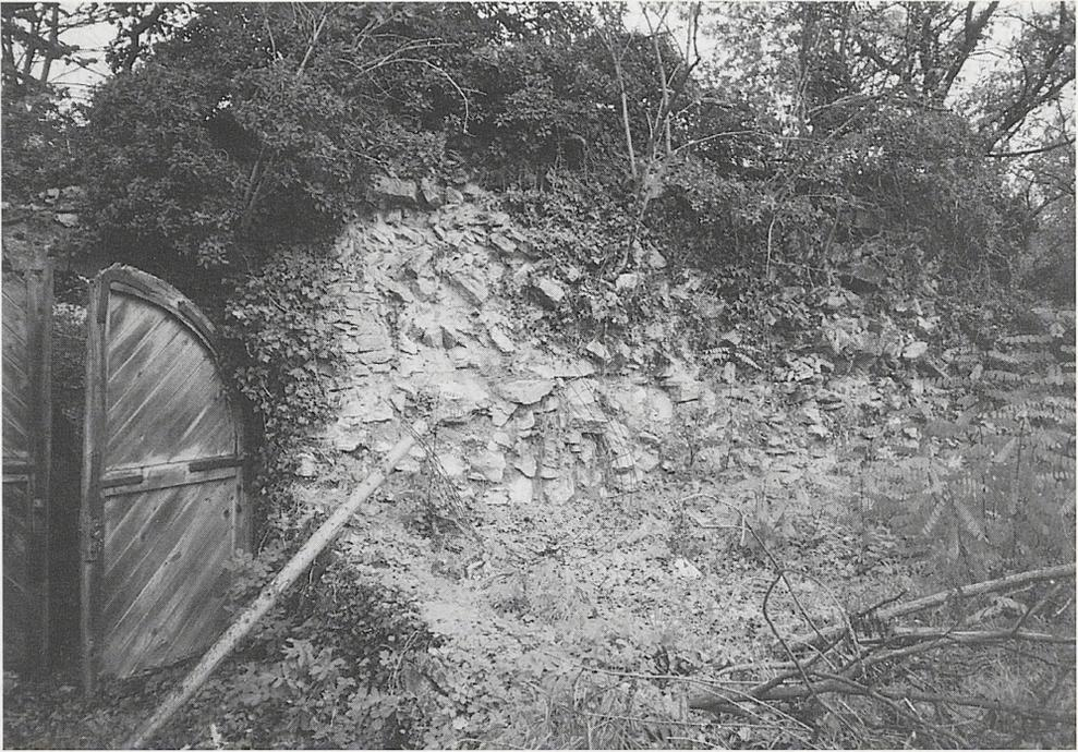
*Abb. 12: Burgruine Forchtenberg. Blick gegen die Innenseite der westlichen Ringmauer vor Beginn der Sicherungsarbeiten. Das offenliegende Kernmauerwerk ist deutlich zu sehen.*
