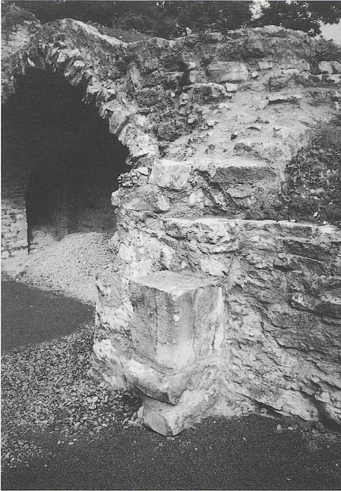
*Abb. 15: Burgruine Forchtenberg: Hofseitiger Eingang zum Westkeller nach der Sicherung. In der Mitte das in situ erhaltene Gewändestück mit der Schwelle. Die Pfanne für das nach innen schlagende Tor ist im Bild verdeckt.*
