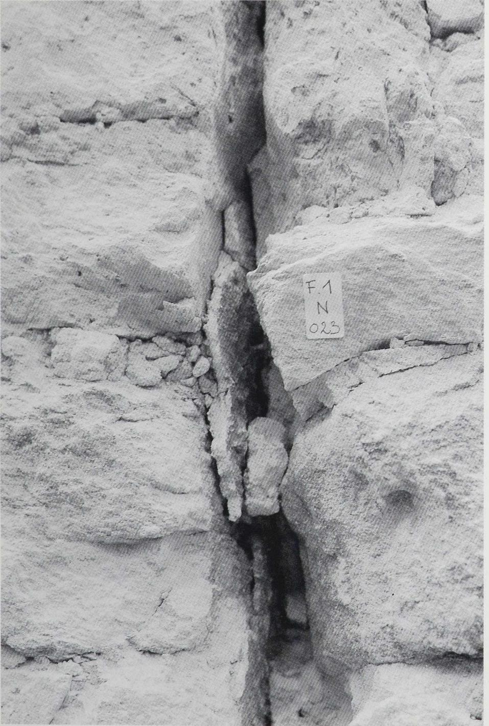
*Abbildung 1: Amtsfronfeste Oschatz, Baunaht im Bereich des 1. Obergeschosses.*
