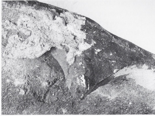
Abb. 10: Ulm, Metzger-turm. Flächenziegel der ältesten Generation, Detail der umgebogenen Nase.
