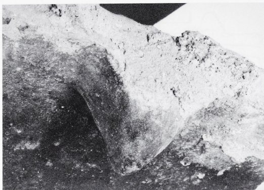
Abb. 15: Ulm, Metzger-turm. Flächenziegel der zweiten Generation. Detail der eingesetzten Nase.
