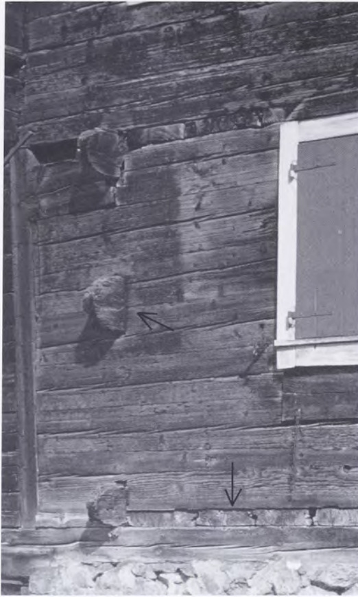
Abb. 106: Kantholzblock mit Einzelvorstößen und fassadensichtigen Bohlen, Morschach (Kt. Schwyz), um 1341 (d).
