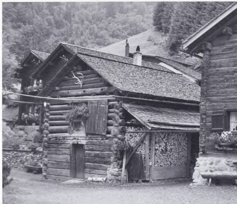
Abb. 76: Rund- und Kantholzblock, St. Martin, Gde. Pfäfers (Kt. St. Gallen).
