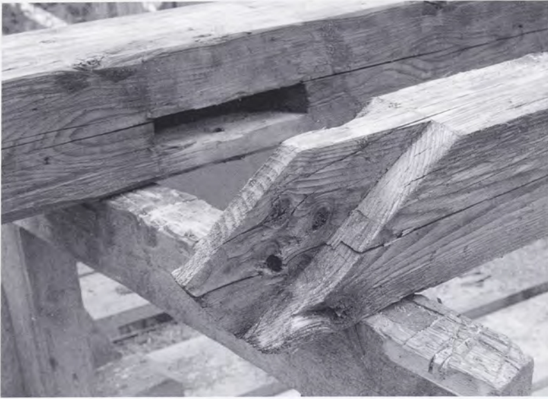
Abb. 46: Gegenholz mit Zapfenloch und Anschlussholz mit Zapfen.
