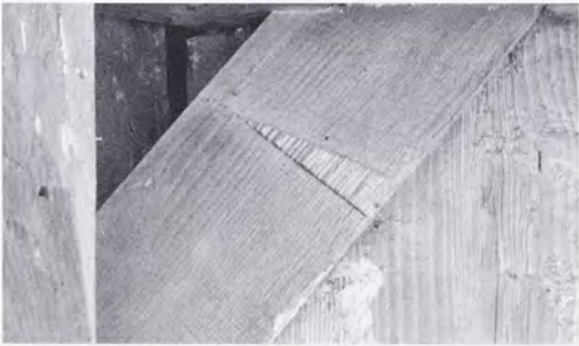
Abb. 19a, b: Sägespuren mit dreieckigen Spaltflächen.
