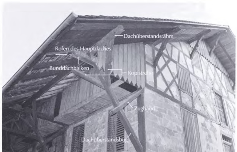
Abb. 185 (unten): Dachüberstand mit zusätzlicher Stützkonstruktion, Schleithen (Kt. Schaffhausen), Bahnhofstraße 15, Stallscheune, um 1900.
