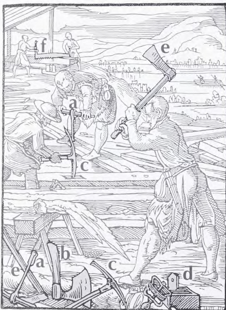
Abb. 15: Die Darstellung von Jost Amman, 1588, zeigt die Arbeiten des Zimmermanns. An der vorderen Bildkante liegen Löffelbohrer (a), Breitbeil (b), Kreuzaxt (c) und Schlagschnur mit Farbkasten (d). Im Vordergrund richtet ein Zimmermann einen Balken mit der Schrotax (e) grob zu, dahinter wird aus einem anderen Balken ein Zapfenloch mit der Kreuzaxt herausgearbeitet und mit dem Löffelbohrer ein Nagelloch gedreht. Im Hintergrund längen zwei Personen einen Balken mit der Schrotsäge (f) ab.
