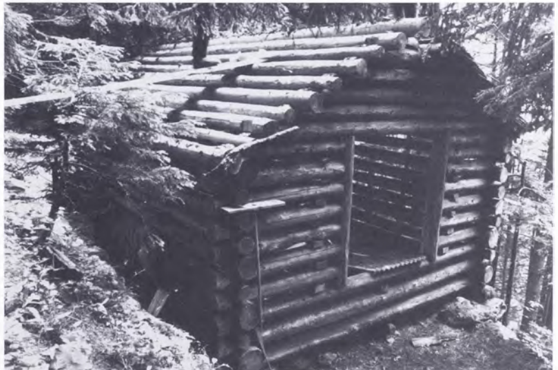
Abb. 82: Offener Rundholzblock mit Blockdach (Dachdeckung abgenommen), Silenen (Kt. Uri).
