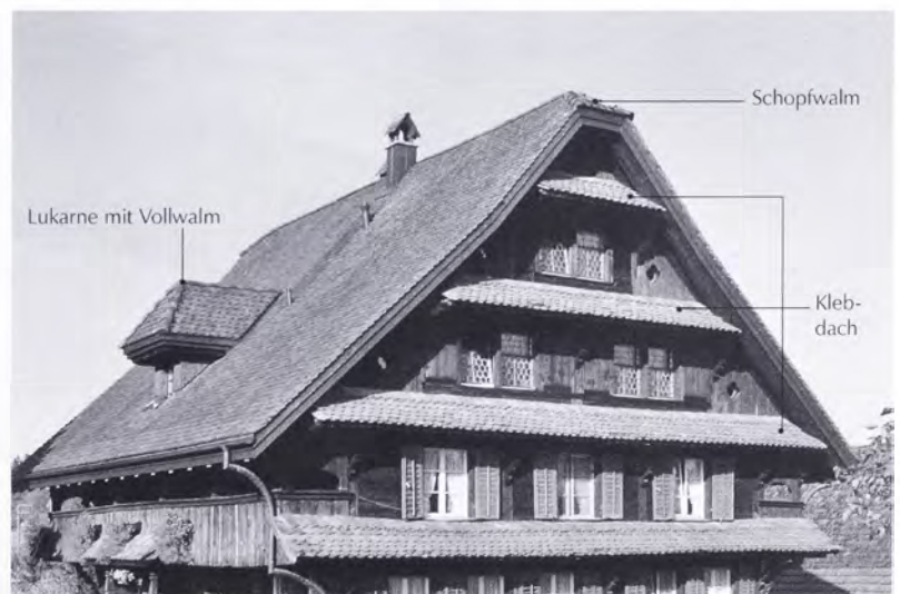
Abb. 192: Klebdach, Konstruktion mit Klebdachstiel.
