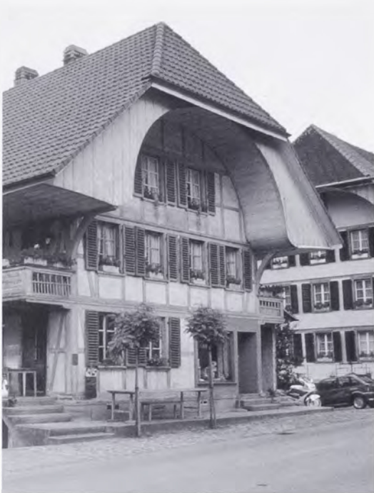
Abb. 186 (rechts): Verschaltes giebel- seitiges Vordach, umgangssprachlich auch Ründli genannt, Signau (Kt. Bern), um 1800.
