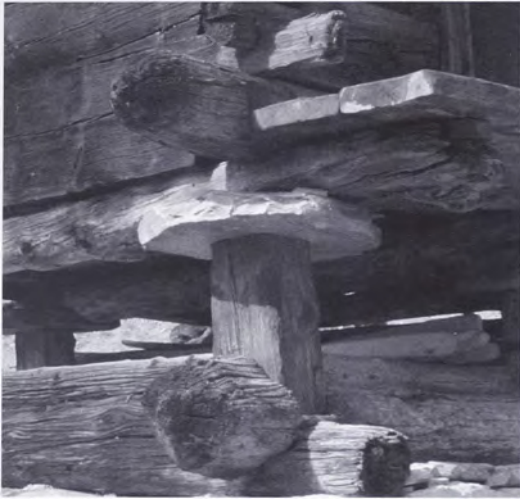
Abb. 117: Stütze mit Mäuseplatte.
