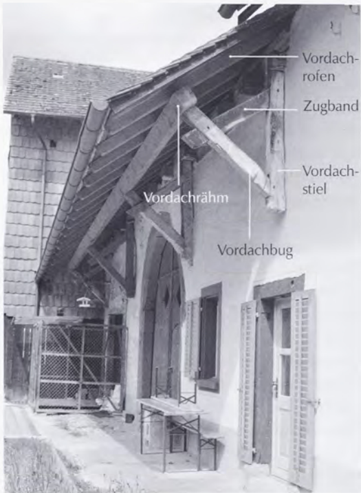
Abb.188 (oben): Vordach an einem Massivbau, Guntmadingen (Kt. Schaffhausen), Heuengasse 6–8, 17./18. Jh.
