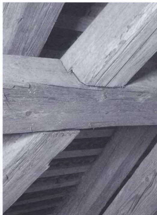
Abb. 51 (links): Blattaufnagelung mit Brust.
