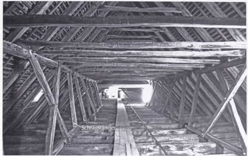
Abb. 178: Gegen die Dachfläche geneigte Längsbünde, Wissembourg (Dép. Bas-Rhin), St. Peter und Paul, Kirche der Benediktinerabtei, Langhausdach, Mittelschiff.
