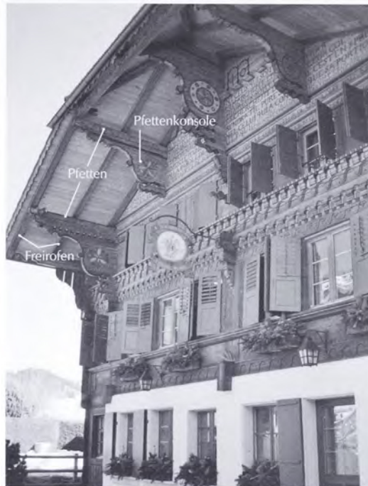
Abb. 183 (oben): Traufseitiger Dachüberstand mit Aufschieblingen, Hochfelden (Kt. Zürich), Dorfstraße 10, 1842 (a).
