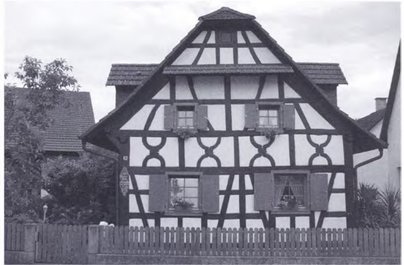
Abb. 122: Haus mit Kniegeschoss, bestehend aus Unterbaustock und Dachstock, Rheinau-Memprechtshofen (Ortenaukreis), Hornisgrindestr. 62, 1790 (i).
