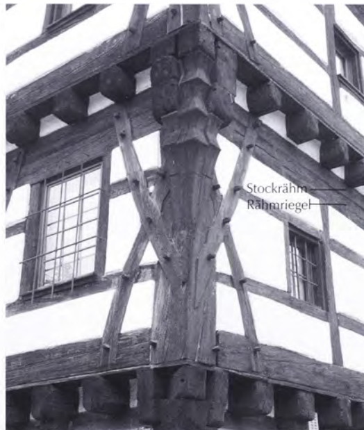
Abb. 136 (links): Zweistöckiges, trauf- und giebelseitig auskragendes Unterbaugerüst, Ettingen, Gde. Kandern (Lkr. Lörrach), Vogts- haus, Im Winkel 4, 1473 (d), heute im Europapark Rust.
