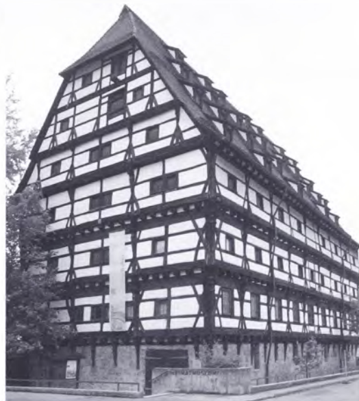
Abb. 134a, b: Einstöckig zweigeschossiges Unterbaugerüst, giebelseitig mit einer Stockwand stöckig abgezimmert. Biberach a. d. Riß (Lkr. Biberach), Zeughausgasse 4, 1319 (d).
