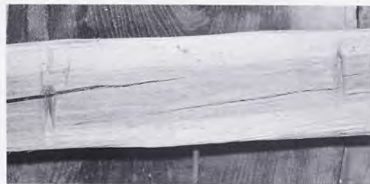
Abb. 29: Zu tief geratene Kerben durch eine Schrotaxt im glätteten Balken.
