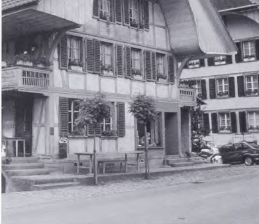
Abb. 187 (links): Vordach an einem Holzgerüstbau, Ramsen (Kt. Schaff- hausen), Oberdorf, frühes 19. Jh.
