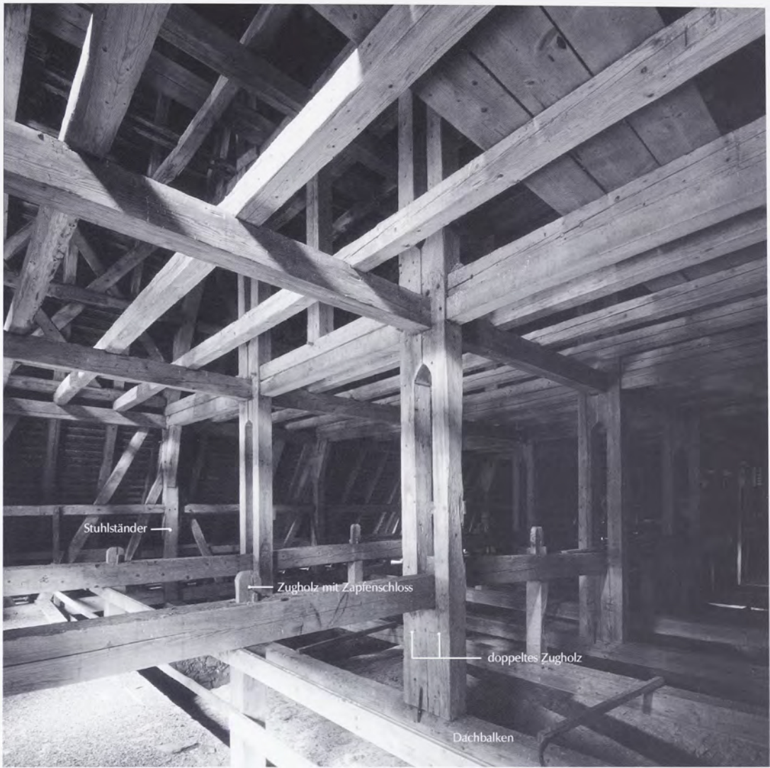
Abb. 199: Querbund im 1. Dachgeschoss kombiniert aus einer zweifach stehenden Unterstützungskonstruktion (zweifach stehender Stuhl) und einem zweifachen Hängewerk. Blau-beuren (Alb-Donau-Kreis), Klosterkirche, Dachwerk über dem Langhaus, 1499 (i).
