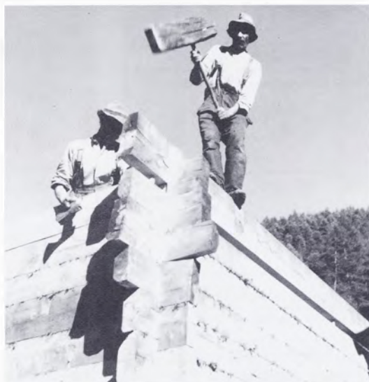
Abb. 43: Aufrichten eines Blockbaus. Die Eckverbindungen werden nicht vorgearbeitet. Evolène (Kt. Wallis), um 1940.
