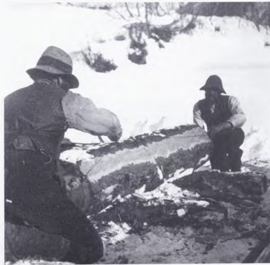
Abb. 24: Arbeit mit der Schlagschnur. Lötschental (Schweiz), 1934.
