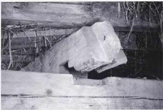
Abb. 53: Verkämmung. (Verbindung geöffnet).
