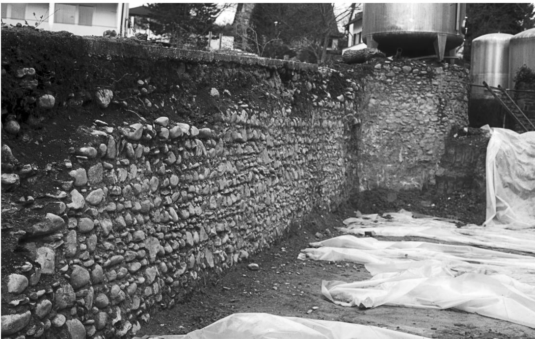
Abb. 6: Staufen, Auf dem Rempart. Freigelegte Teile der Stadtmauer beim Bau der Winzergessenschaft 1991.
