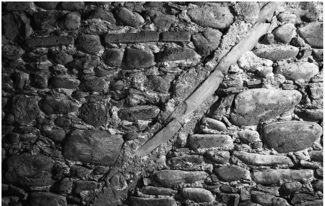
Abb. 234: Kirchstraße 2, Scheune, Giebelortgang, Detail.
