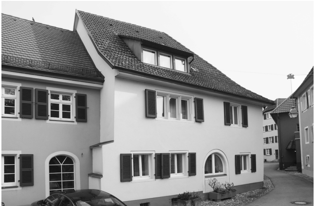
Abb. 57: Freihofgasse 1, südlicher Abschluss hinter der abgetreppten Traufwand von Haus Nr. 5.
