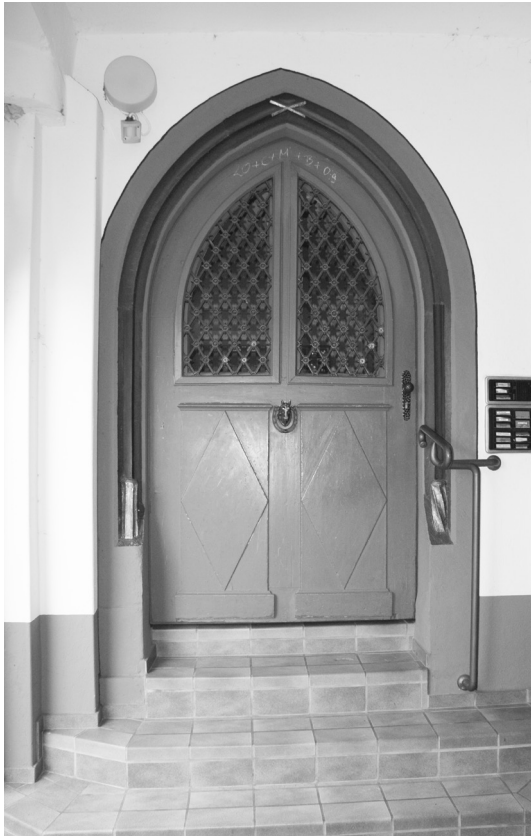
Abb. 109: Hauptstraße 34, Eingangportal, vor 1500.
