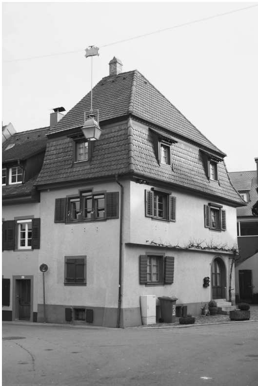
Abb. 304: Spitalstraße 1, Ansicht von Südost.
