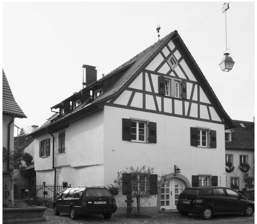
Abb. 329: Spitalstraße 20, Ansicht von Nord.
