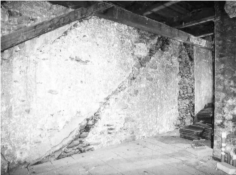
Abb. 107: Hauptstraße 33, südlicher Hausteil, Blick auf die Südwand im 1. Dachgeschoss.
