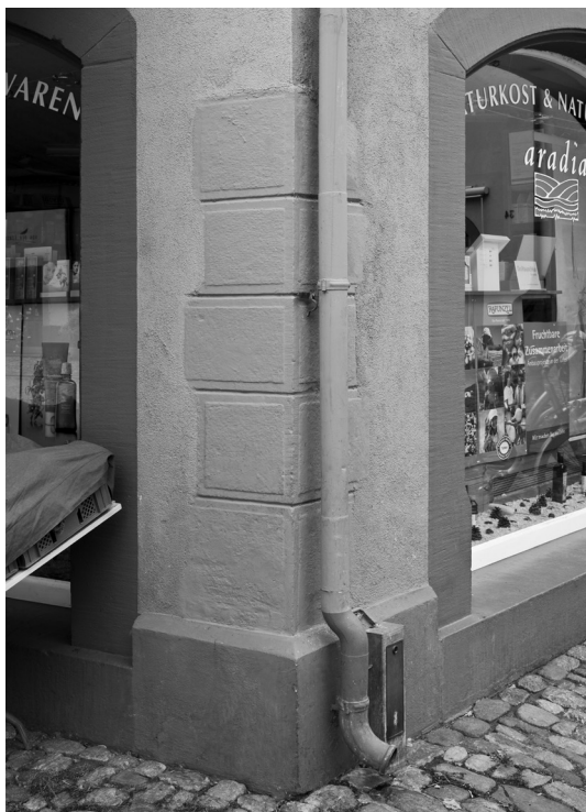
Abb. 18: Hauptstraße 38, Detail Eckquader.
