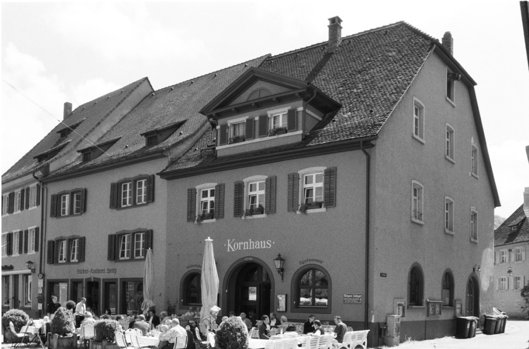
Abb. 186: Hauptstraße 57, ehem. Kornhaus.
