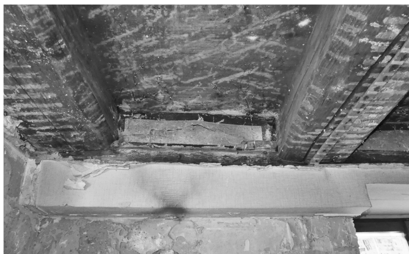
Abb. 243: Kirchstraße 8, Farbfassung zwischen den Deckenbalken über dem Erdgeschoss.
