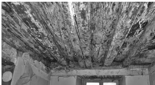
Abb. 349: Spitalstraße 33, Erdgeschoss, Detail der Bretter-Balken-Decke.
