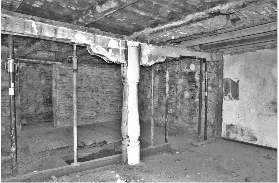
Abb. 357: Spitalstraße 33, 1. Obergeschoss, Säule mit Sattelholz, 18. Jh.
