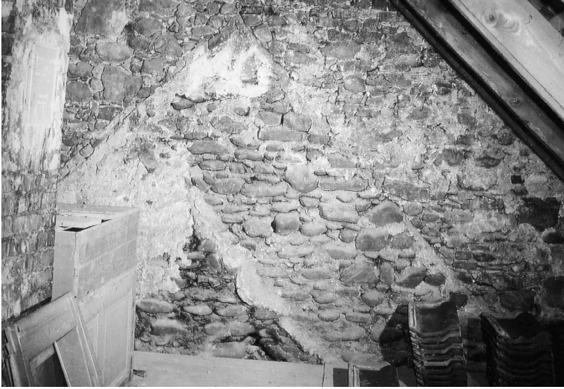
Abb. 106: Hauptstraße 33, südlicher Hausteil, Blick auf die Südwand im 2. Dachgeschoss.
