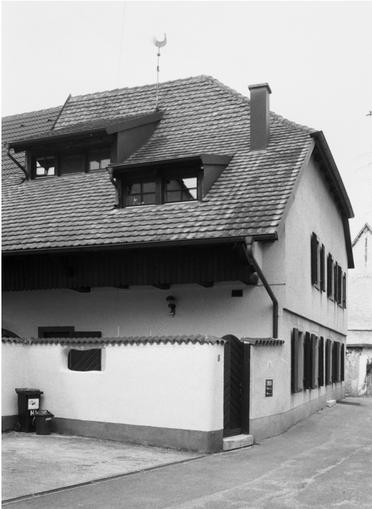
Abb. 214: Jänergasse 8, ehem. Scheune.
