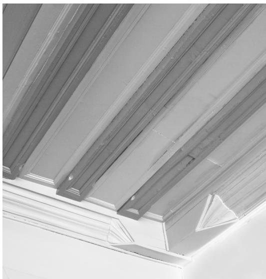
Abb. 167: Hauptstraße 53, Rathaus, Decke im Festsaal, Detail.
