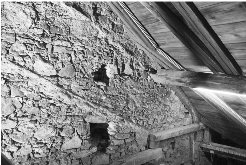
Abb. 267: Kirchstraße 17, St. Martin, Dachanschlüsse an der Hochschiffwand.
