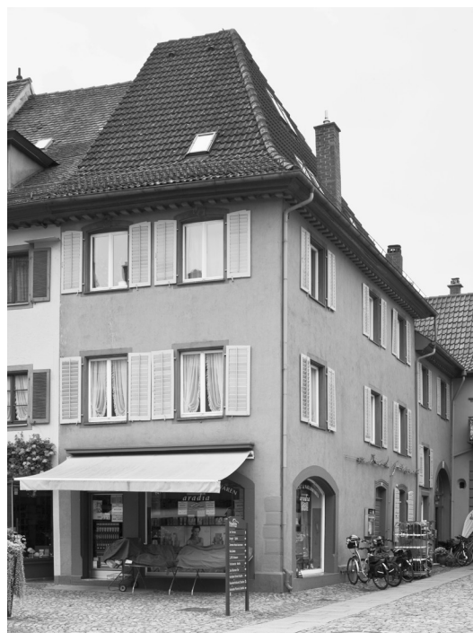
Abb. 119: Hauptstraße 38, Gesamtansicht des Eckhauses.
