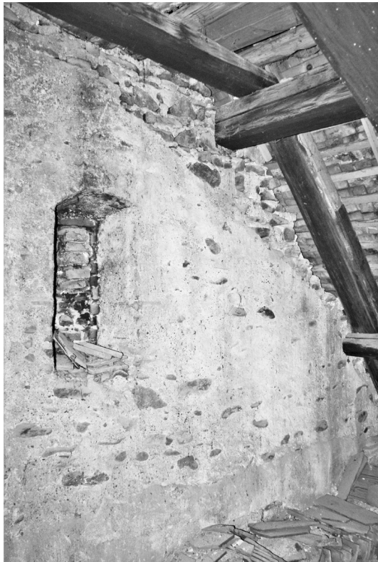
Abb. 30: Adlergasse 3, Nordgiebel. Die Putzgrenze zeichnet die Kontur eines ehemaligen, vor dem Giebel verzimmerten Dachholzes nach.
