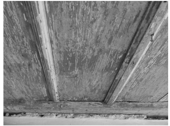
Abb. 208: Im Grün 27, Detail der bauzeitlichen Deckenverkleidung.
