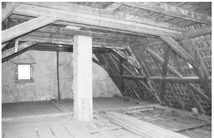
Abb. 47: Auf dem Graben 12, Blick in das um 1672(d) abgezimmerte Dachwerk des Kernbaus.
