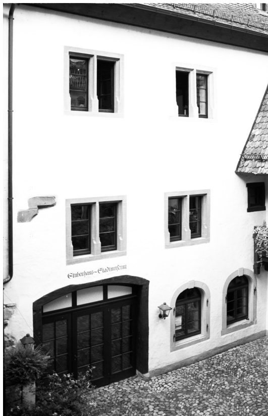
Abb. 180: Hauptstraße 56a, Stubenhaus.
