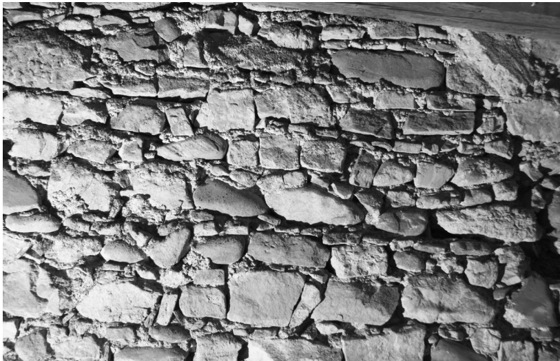
Abb. 266: Kirchstraße 17, Kirchturm St. Martin, ursprüngliches Mauerwerk.
