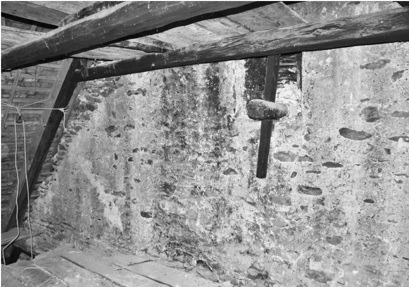
Abb. 34: Adlergasse 3, Südgiebel, 2. Dachgeschoss. Verklammerung mit Haus Nr. 5.
