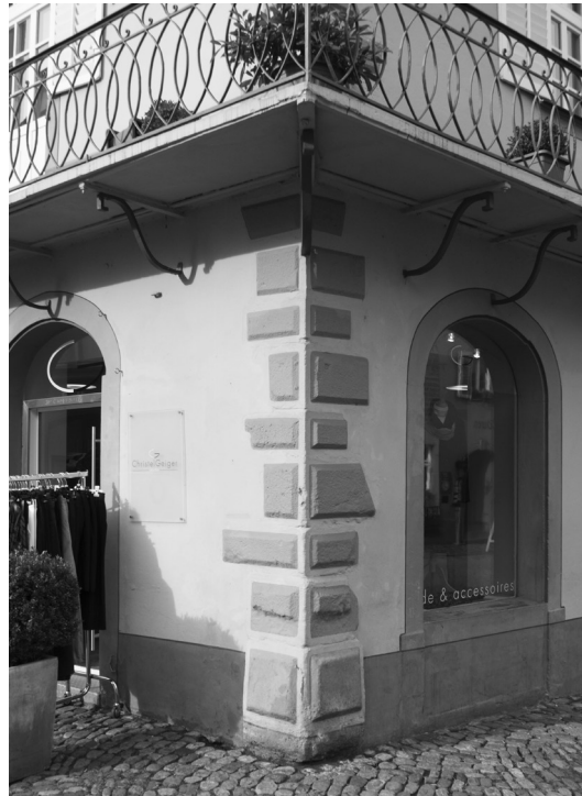
Abb. 17: Hauptstraße 58 mit Buckelquaderecke und leichter Abschrägung im unteren Bereich.
