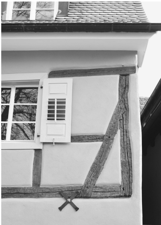
Abb. 283: St. Johannesgasse 2, Detail Eckständer.
