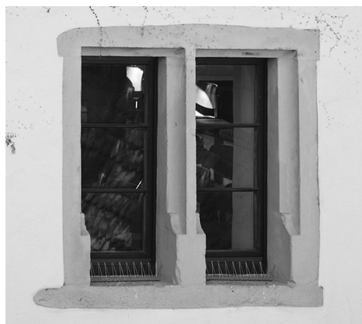
Abb. 182: Hauptstraße 56a, Rest des bauzeitlichen Eingangsturzes im 1. Obergeschoss.
