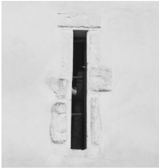
Abb. 265: Kirchstraße 17, Kirchturm St. Martin, Schlitzfenster im 1. Obergeschoss.
