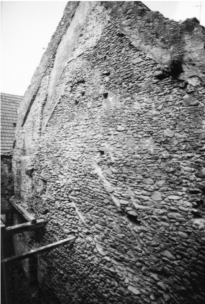
Abb. 144: Hauptstraße 46, nördliche Brandwand im Bereich des rückwärtigen Hofgebäudes.
