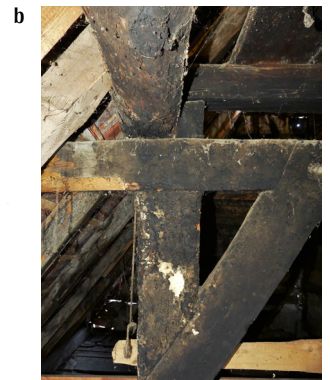
14 Mössingen, Mitteltgasse 24/26, 1432 (d). a: Querschnitt, Rekonstruktion. b: Detail Ständerkopf.
