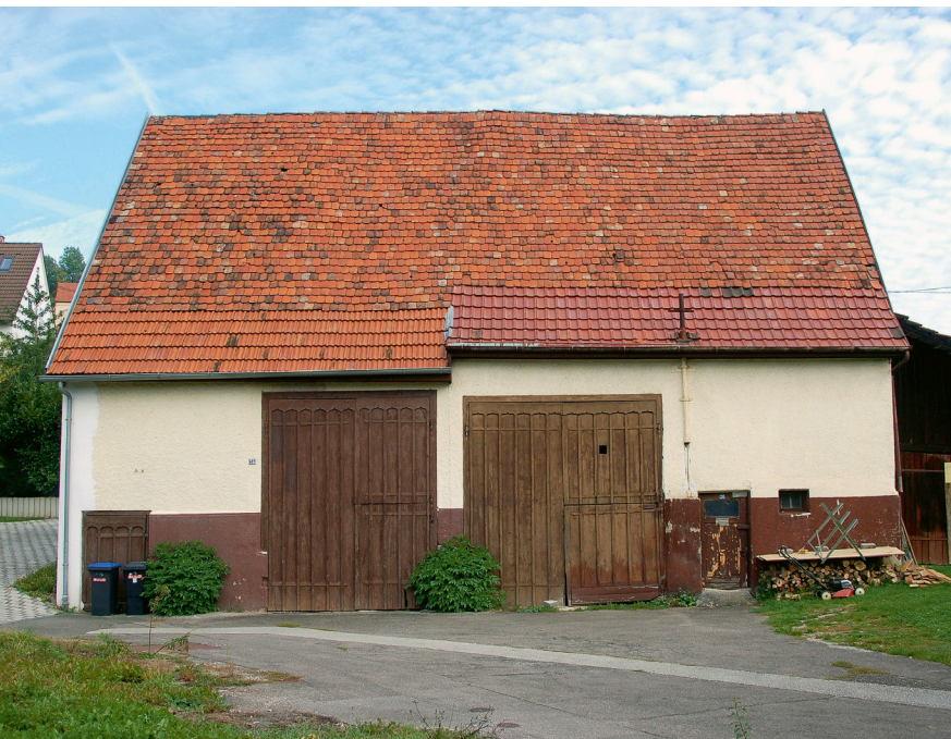
17 Zizishausen, Im Höfle 22–22/1. Außenansicht der Scheune vor dem Abbruch. Der dreizonige mittelalterliche Bau mit mittiger Tenne (linkes Scheunentor) wurde nachträglich zweigeteilt, mit einer zweiten Tenne versehen (rechtes Scheunentor) und um eine vierte Zone (ganz rechts) zu zwei symmetrischen Hälften erweitert.
