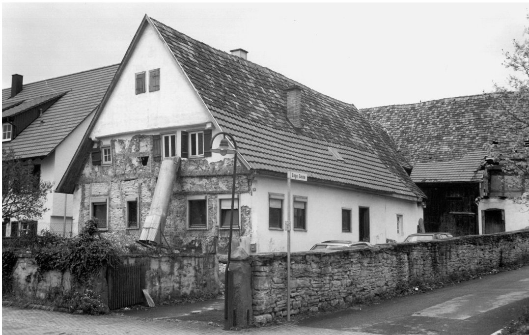
1 Gärtringen, Kirchstraße 20. Außenansicht des Gebäudes vor dem Abbruch. Die spätmittelalterliche Firstständerkonstruktion ist zur Gänze hinter der jüngeren Giebelscheibe verschwunden.
