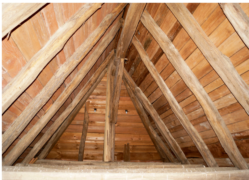
4 Michelstadt, ev. Stadtkirche, Abdrücke eines früheren Dachwerks mit Firstständer über dem Mittelschiff an der Westseite des gemauerten Westgiebels des Chordachs, Ausschnitt aus einer zeichnerischen Bauaufnahme, 2005
