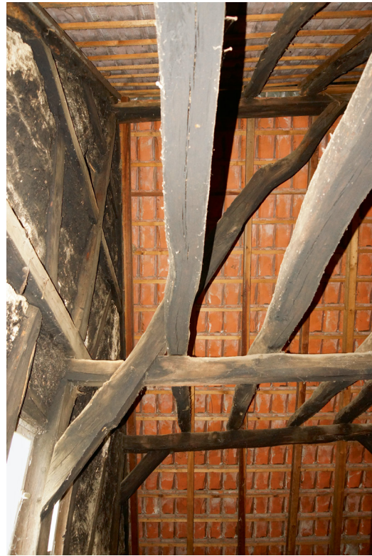
8 Ober-Mumbach (Mörlenbach), Mumbacher Talstraße 176, Firstständerlängsbund im Spitzboden, 2023
