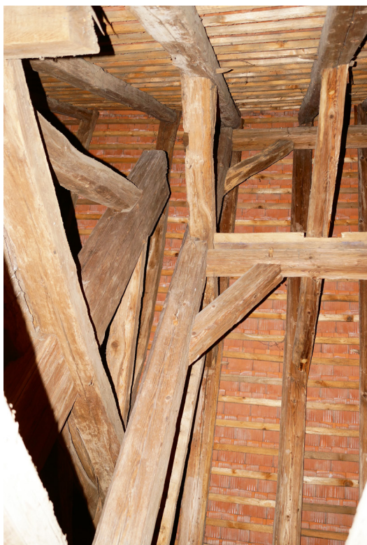
2 Bad Vilbel, ev. Auferstehungskirche, obere Hälfte des östlichen Firstständers im westlichen, mittelalterlichen Teil des Schiffsdachs, 2013
