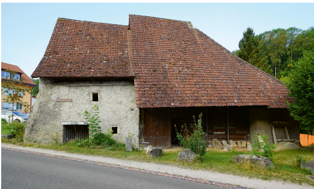
13 Hochfirstständerbau mit versteinerter Ökonomie und hölzernem Wohnteil in Buus (BL), Rickenbacherstrasse 16, Archiv-Nr. 18.041 von 1576–77 (d), Typ 1a. 2020.
