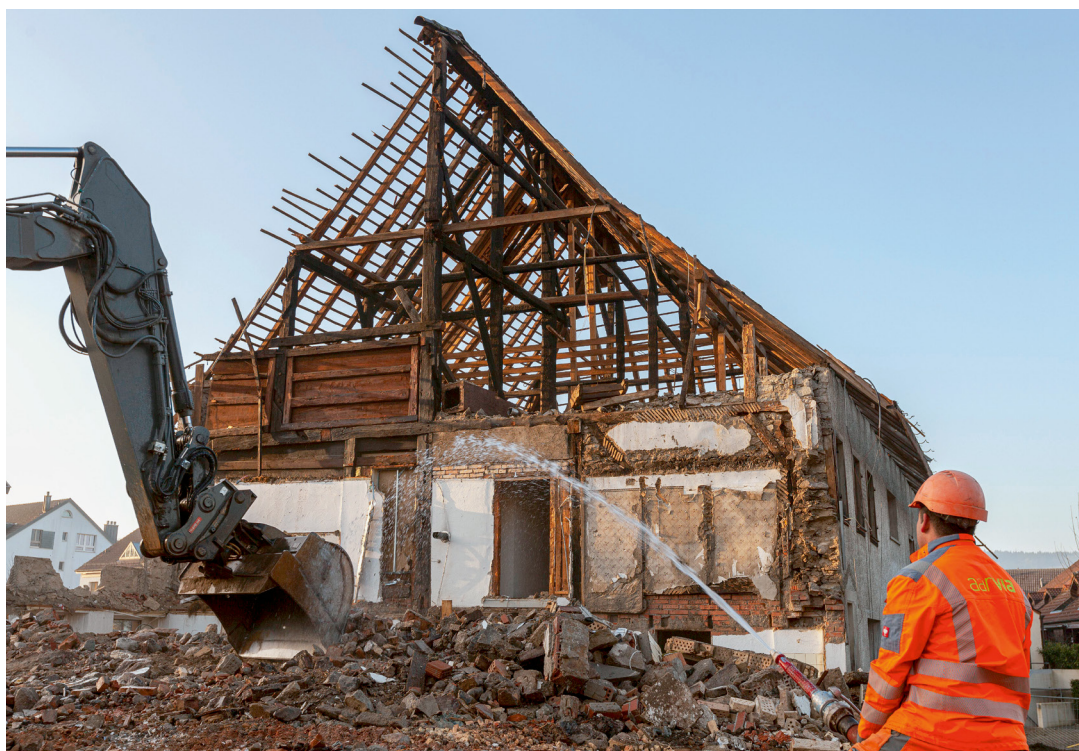
1 Abbruch eines firstbezogenen Firstständerbaus mit stehender Dachstuhlkonstruktion in Würenlos (AG), Vers.-Nr. 96, Archiv-Nr. Wur.021.1 von 1561–64 (d), Typ 1c. 2021.
