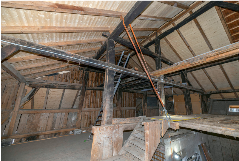
7 Hochfirstständerkonstruktion in Auw (AG, südliches Freiamt), Vers.-Nr. 107, Archiv-Nr. Auw.022.1 von 1457–59 (d), Typ 2a. 2022.
