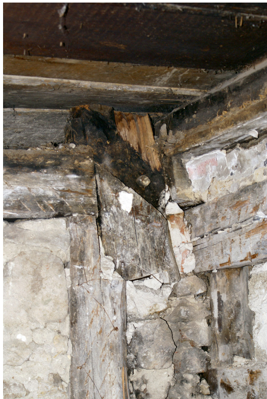
3 Sindelfingen, Hintere Gasse 8, bei der ersten Begehung des Hauses 2013 als in situ erhalten identifizierte und beprobte Teile des Hochfirstgerüsts von 1362/63 (d): Hochfirstständerfragment im zweiten Querbund (links); „Triangel“ im dritten Querbund des Dachwerks (rechts)
