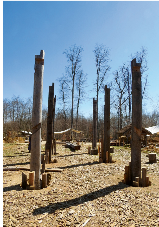
14 Scheune des Campus Galli bei Meßkirch: Aufrichten der Pfosten von März-April 2021 unter Nutzung der Pfosten-gruben als Aufrichthilfe
