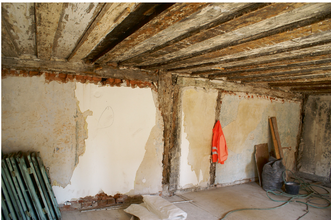
1 Sindelfingen, Hintere Gasse 8, Blick in die Stube mit durchgängiger und in Teilen aus Lindenholz gefertigter Balken-Bretter-Decke von 1488/89 (d)
