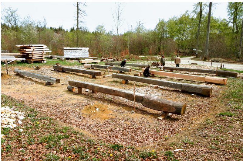
13 Scheune des Campus Galli bei Meßkirch: Auslegen der 2019–2020 bearbeiteten Eichenpfosten des Innengerüsts (oben); Erstabband im Laufe der Saison 2020 (unten)
