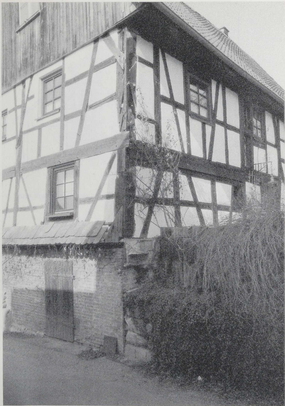
Abb. 5: Gaildorf-Münster, Spatzengasse/Ecke Brunnengasse, Teilansicht von Südosten 1992. Gut zu erkennen sind die geschoßübergreifenden Ständer und Blattsitze bzw. die Reste der Ausstrebung.
