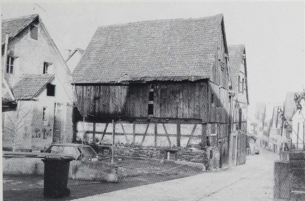
Abb. 2: Schwäbisch Hall, Scheune Blendstatt 31, Zustand 1984.
