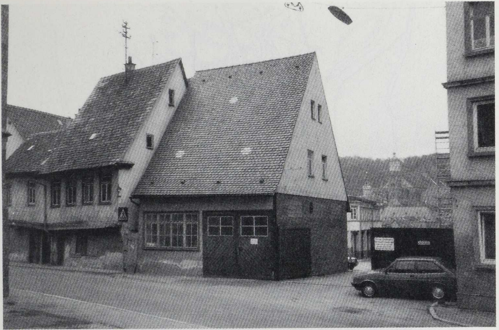
Abb. 6: Schwäbisch Hall, spätmittelalterliche Scheune Lange Straße 35, Aufnahme 1992.
