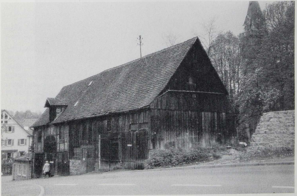
Abb. 5: Schwäbisch Hall, Doppelscheune Baintdgasse 10, Aufnahme 1992.
