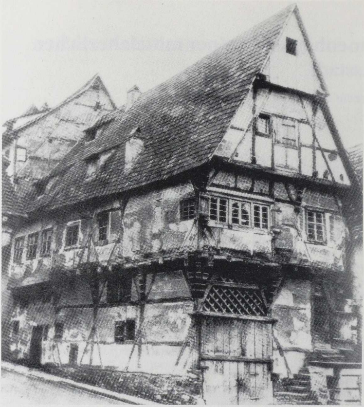
Abb. 1: Schwäbisch Hall, ehem. "Ackerbürgerhaus" Lange Straße 2 in einer historischen Aufnahme vor 1890.
