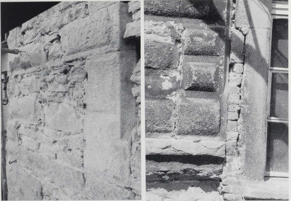
Abb. 12: Konstanz, Katzgasse 3. Detailphoto der Hoffassade in Höhe des ursprünglichen Saalgeschosses. Fragmente des ursprünglichen Fensterbandes und der Eckquaderung sind noch erhalten. Die bossierten Steine dienten der Betonung der Architekturteile, dazwischen deutlich die nicht als Sichtmauer ausgebildete Wandfläche. Das ehemalige Gurtgesims (im Photo unten) wurde abgeschlagen.
