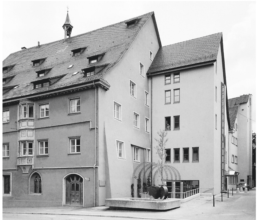
Abb. 4: Rottweil. Das Spitalgebäude heute.
