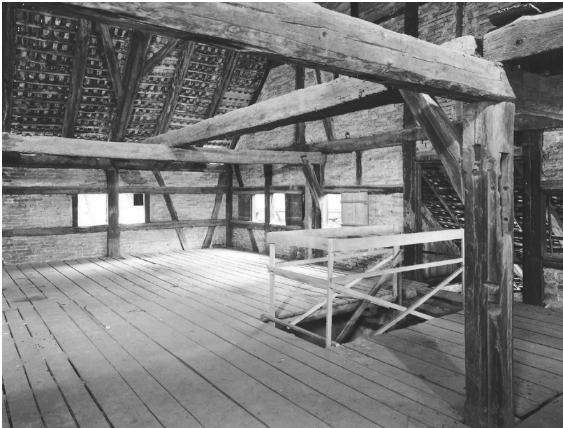
Abb. 16 (oben): Stein am Rhein, Bürgerasyl. Mittelbau, Inneres des Obergeschosses gegen Süden. In der Südfassade Türöffnung gegen Laube und Fensteröffnung, vor 1535, beide zugemauert 1535 (a).
