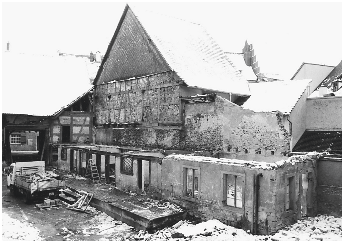
Abb. 33: Stein am Rhein, Bürgerasyl. Nebengebäude von Südwesten während Abbrucharbeit 1999. Rechts im Vordergrund das Waschhaus.
