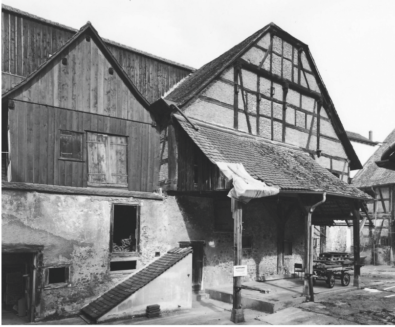
Abb. 31: Stein am Rhein, Bürgerasyl. Mittelbau, Ostfassade mit Wagenschopf und gegen Süden angebaute Stallscheune, Zustand 1996.
