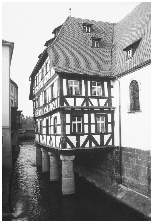
Abb. 4: Forchheim, St.-Katharina-Spital, in der Wiesent stehender Teil des Pfründnerbaus.
