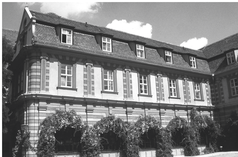
Abb. 3: Würzburg, Bürgerspital, sog. Roter Bau, neuzeitlicher Pfründnerbau.
