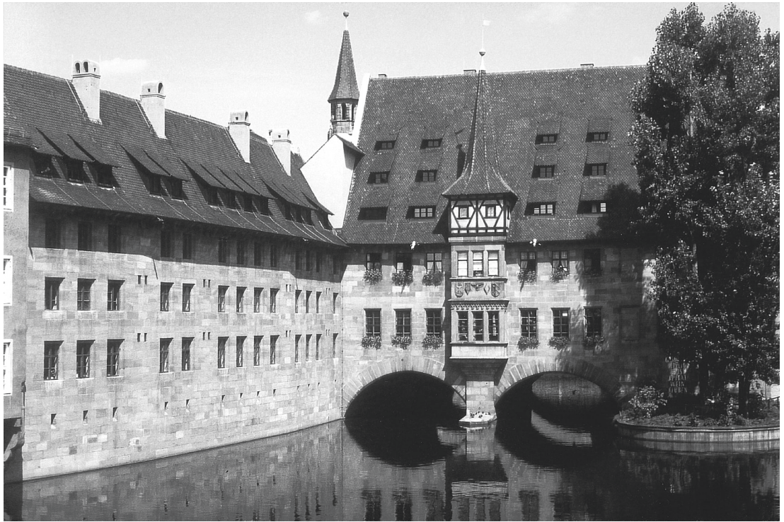
Abb. 5: Nürnberg, Heilig-Geist-Spital, Erweiterung der Pfründnerkapazitäten mit dem Beheim-Bau.
