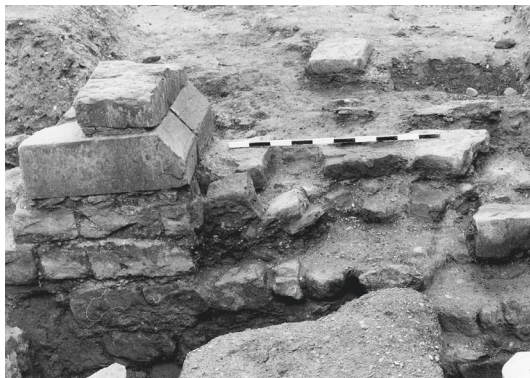
Abb. 13 (unten): Heidelberg, Kornmarkt. Ostwand der Hospitalhalle mit dem südwardigen Schrägsockel des ehemaligen Portals zur Kapelle (Ansicht von Osten).
