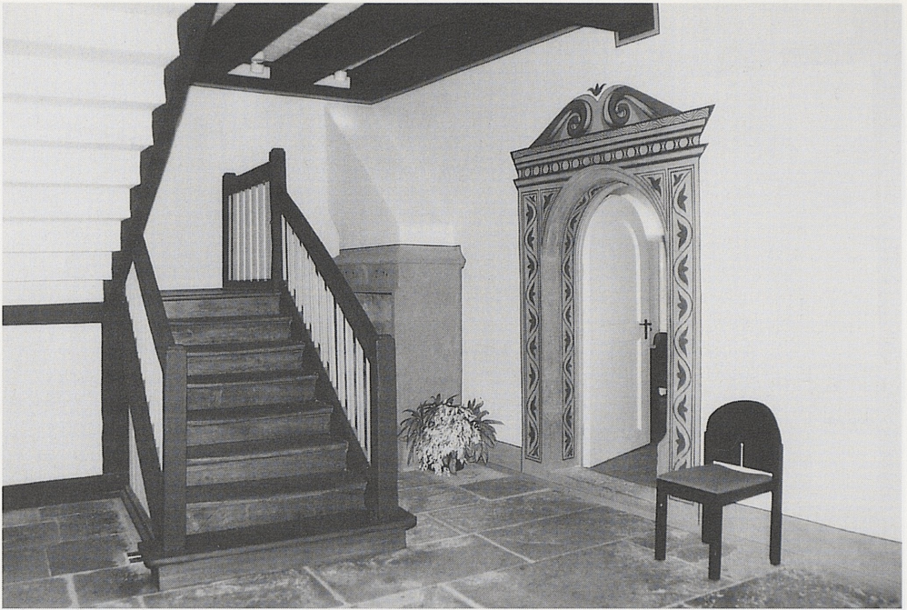
Abb. 17: Schloss Dallau, Flurbereich im ersten Obergeschoß nach der Restaurierung. Aus der Umbaumaßnahme im Jahre 1529 stammen die Massivwand mit Sandsteinportal und die Kaminanlage zur Beheizung der großen Stube rechts.
