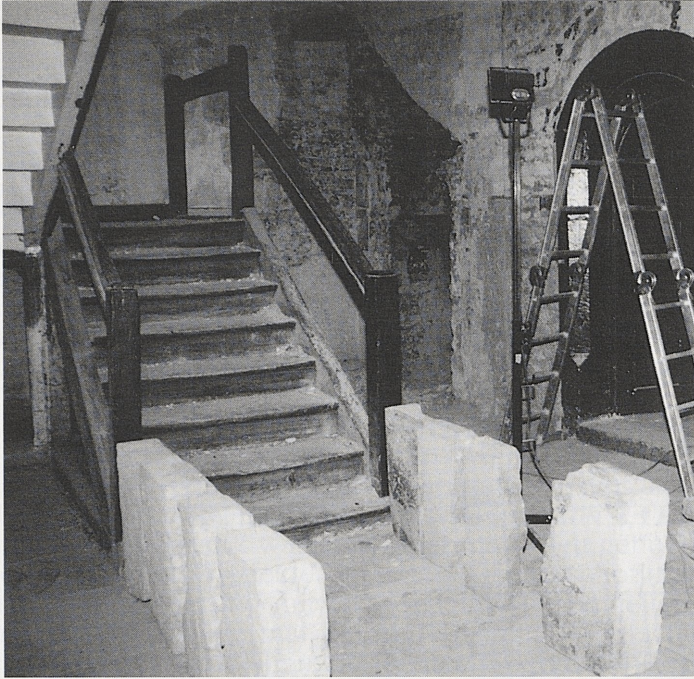
Abb. 11: Schloß Dallau. Teile des Kaminvorbaus bzw. Schürhauses nach der Bergung. Im Hintergrund das freigelegte Schürloch und der Abdruck des schrägen Rauchabzuges.
