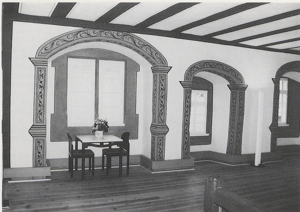
Abb. 16: Schloss Dallau. Diele im zweiten Obergeschoß nach der Restaurierung. Die unterschiedlichen Größen der einzelnen Fensternischen veranschaulichen den dynamischen baulichen Veränderungsprozeß dieses Gebäudes.
