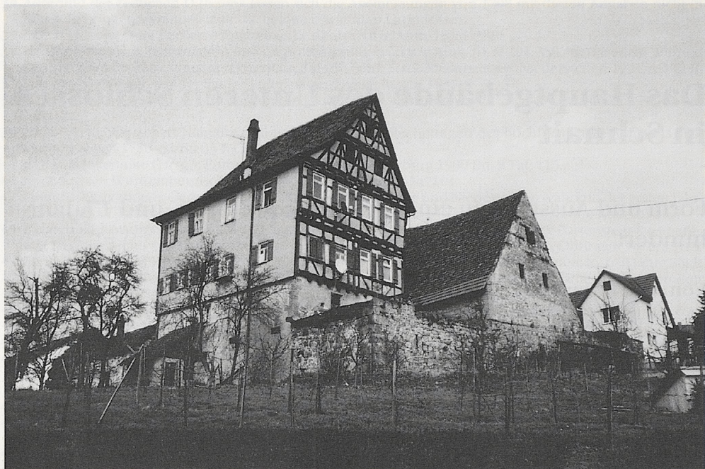
Abb. 1: Schnait, Unterer Schloß, Silcherstraße 10. Ansicht von Südwesten. Zu sehen ist der Westflügel mit der nach Süden weisenden Giebelfassade, dahinter die 1528 errichtete Scheune, die Ringmauer und im Hintergrund das jüngere Gebäude Silcherstraße 14.
