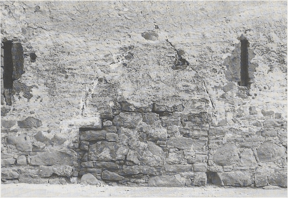
Abb. 7: Bildechingen, ehemalige Zehntscheuer. Blick auf den ursprünglichen Zugang in der Mitte der Nordwand. Von der Werksteineinfassung ist nur der östliche Kämpfer (links) erhalten.
