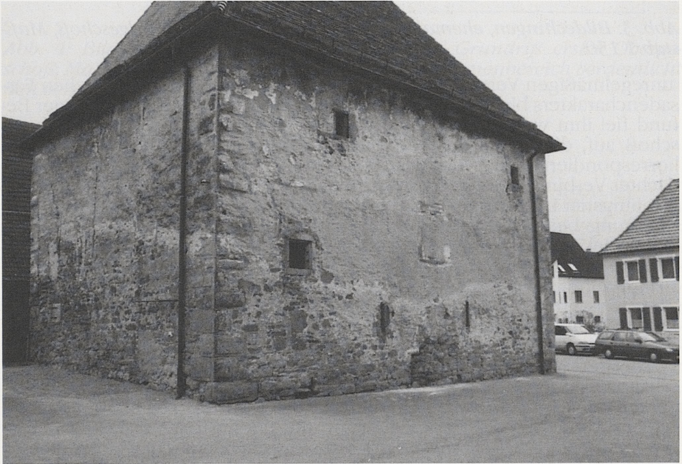
Abb. 2: Bildechingen, ehemalige Zehntscheuer. Ansicht von Nordosten.
