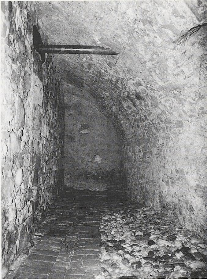
*Abb. 6: Meßkirch, Schlößle. Blick durch den südlichen Keller nach Westen. Die linke Mauer wurde nachträglich als Unterfangung der Hoffront in den älteren, ursprünglich größeren Keller eingestellt.*
