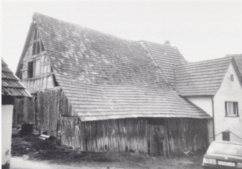
Abb. 1: Unterschwarzach, Ziegelei, Schwanheimer Straße 13. Ansicht von Nordwesten im Jahre 1991. Während der Produktionsbereich der Ziegelhütte seit ihrer Stilllegung nach der Jahrhundertwende einem kontinuierlichen Verfallprozeß ausgesetzt war, wurde der bewohnte Teil bis in die 80er Jahre dieses Jahrhunderts genutzt. Die Verbretterung der ursprünglich offenen Ziegeleibereiche stammt nach mündlicher Überlieferung aus den 30er Jahren.
