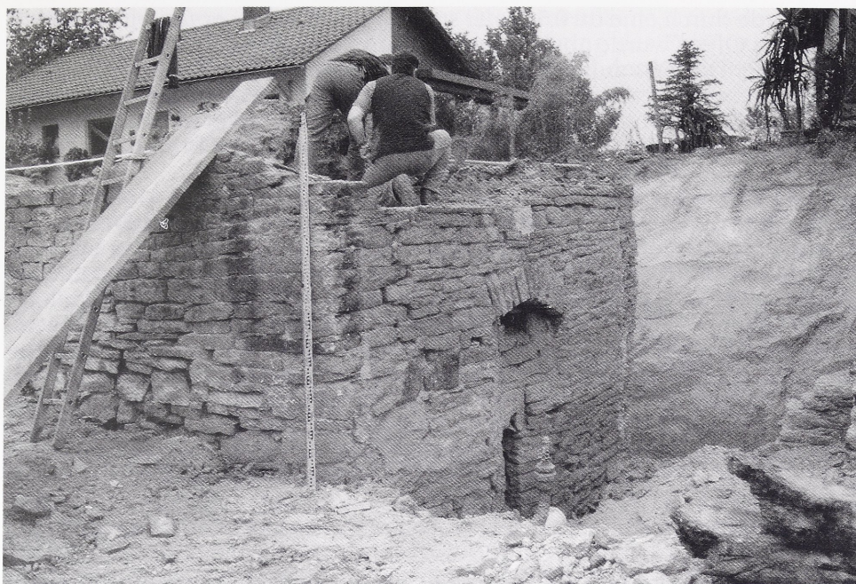
Abb. 15: Unterschwarzach, Ziegelei, Schwanheimer Straße 13. Brennofen während der Vorbereitung zur Translozierung. Blick auf den tief in der Erde sitzenden Brennofen mit ursprünglicher Schürwand. Die Umfassungs- und gleichzeitigen Stützwände der ehemaligen Schürhalle (R. 004) sind schon abgetragen. Hinter dem Ofen wurde eine Arbeitsgrube geschaffen, um das Tragkorsett anzubringen. Bis in die 80er Jahre dieses Jahrhunderts war der Wohnteil der Ziegelei noch bewohnt, ein in unmittelbarer Nähe errichteter Neubau (siehe Bildhintergrund) ersetzte diesen dann.
