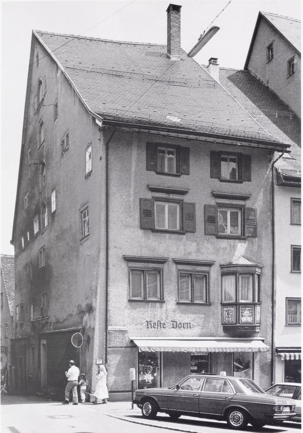
Abb. 2: Rottweil, Hochbrücktorstraße 19, Ansicht von Nordwesten.
