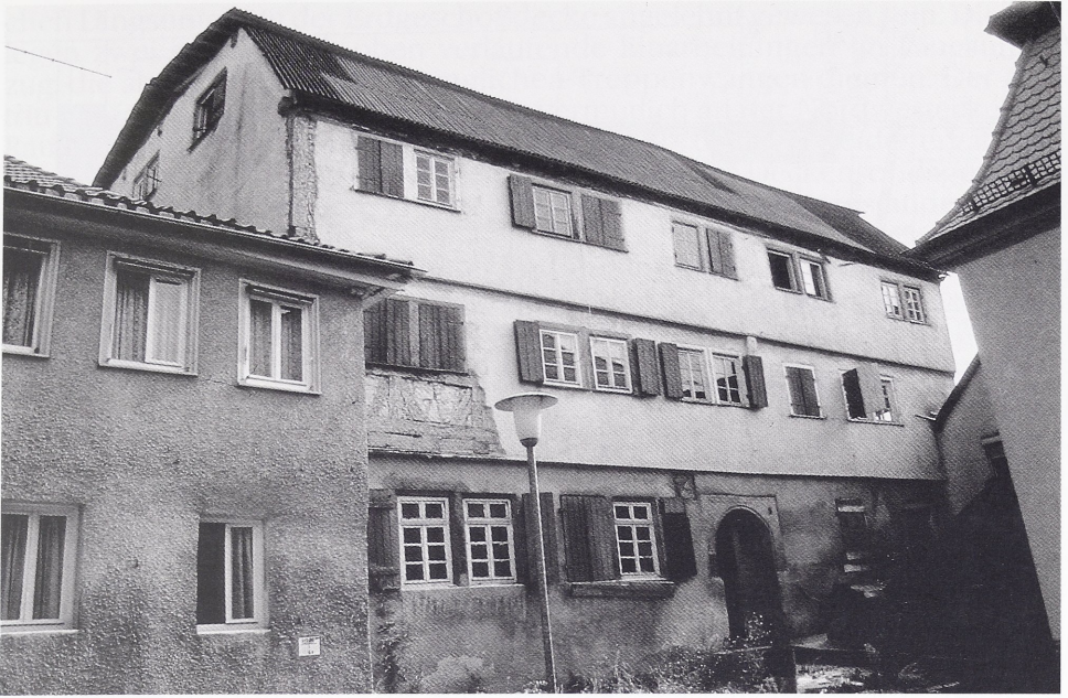
Abb. 2: Öhringen, Seelhaus. Südwestansicht.
