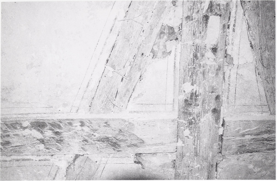
Abb. 11: Öhringen, Seelhaus. Ostwand von Raum 3.09, Farbfassung des 16. Jahrhunderts auf den Bruchsteinausfachungen der Gebäudeaußenwand.
