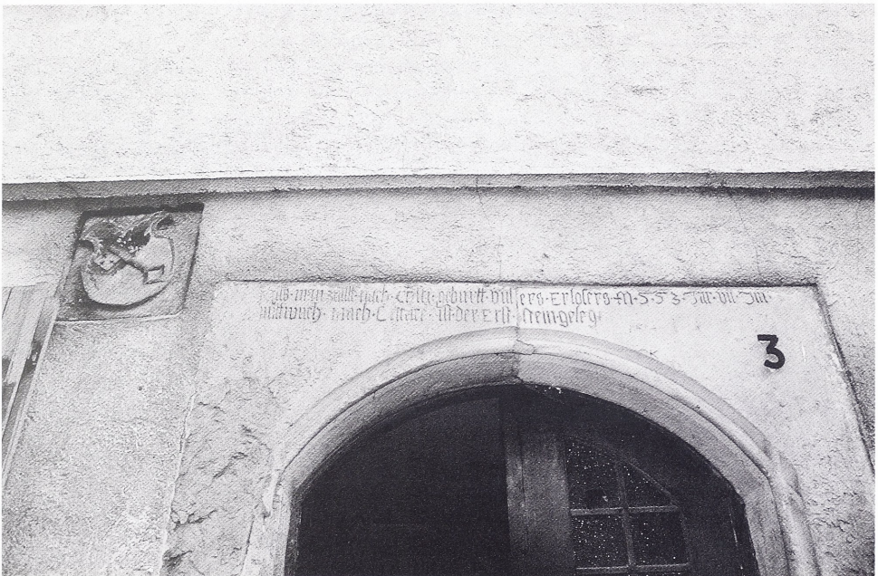
Abb. 12: Öhringen, Seelhaus. Eingangportal der Südfassade mit spätgotischem Werksteingewände, Bauinschrift von 1553 und Wappen mit dem Öhringer Schlüssel.
