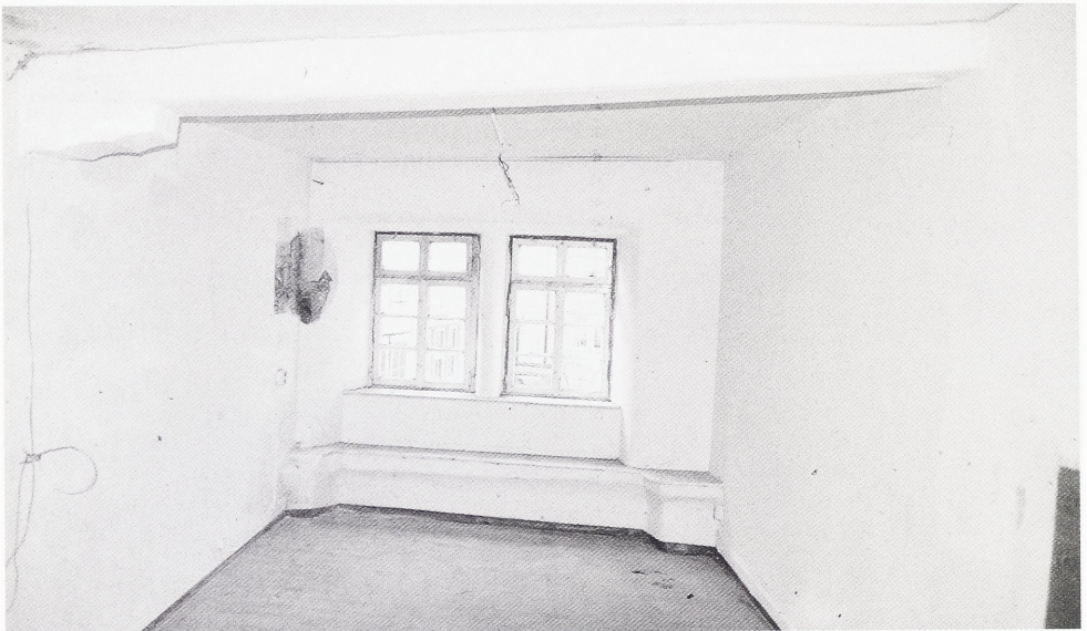
Abb. 14: Öhringen, Seelhaus. Raum 0.03, Blick nach Süden. In der Fenster- nische eine steinerne Sitzbank, die sich entlang der Südwand von Raum 0.02 fortsetzt.
