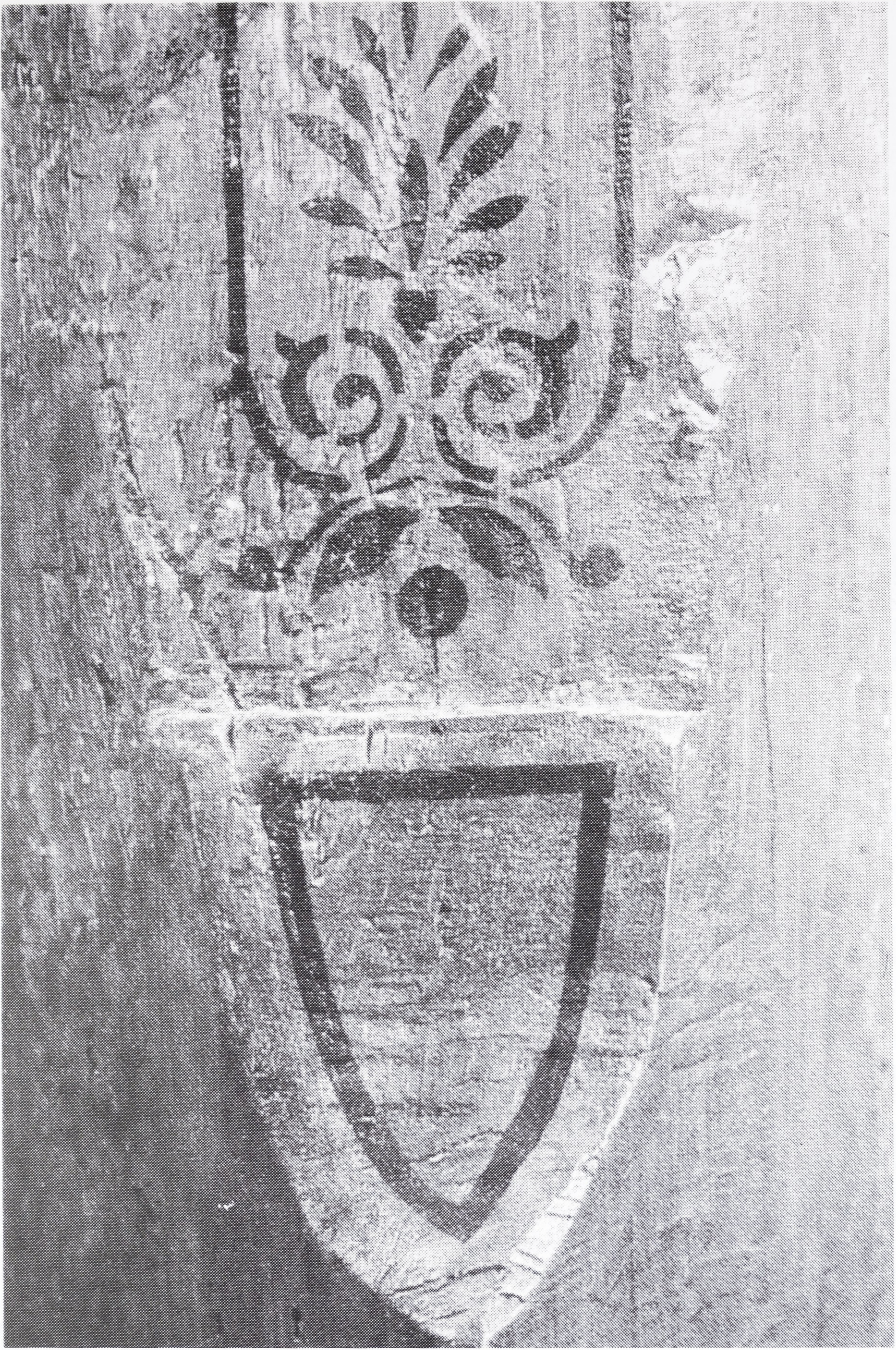
Abb. 12: Nürtingen, Rathaus. Detail eines Ständers im nördlichen Obergeschoßbereich. Die gefasteten Kanten einiger Ständer weisen eine Schablonenmalerei aus Voluten, Palmetten und einfachen Blattmotiven auf, die vermutlich während des Umbaus 1808–10 entstand.
