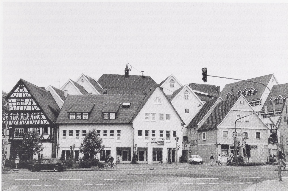
Abb. 19: Nürtingen, Rathaus. Ansicht des erweiterten Rathausareals von Süden.
