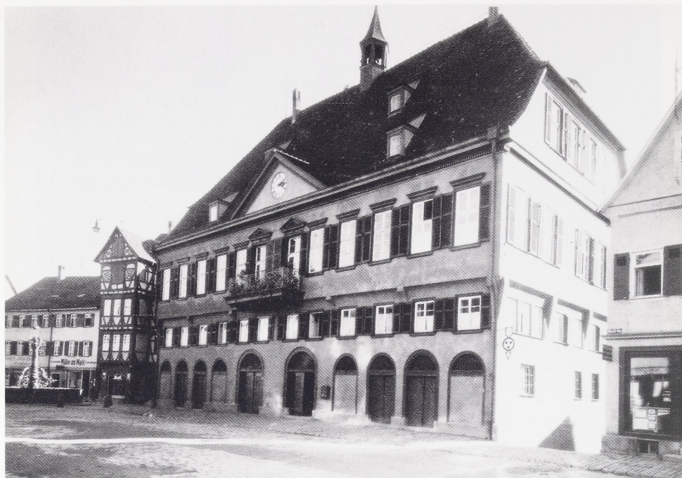
Abb. 13: Nürtingen, Rathaus. Ansicht von Nordwesten nach 1913/14. Die historische Fotografie zeigt die Gestaltung der Fassade nach klassizistischem Stil von 1808–10 mit Betonung der Mittelachse.
