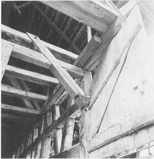
Abb. 6: Murrhardt-Hausen, Scheune im Burgbergweg. Blick von innen gegen Traufe und Dachbalkenanschluß des im späten 18. Jahrhundert entstandenen Baues mit einem einzelnen verblatteten Bug.
