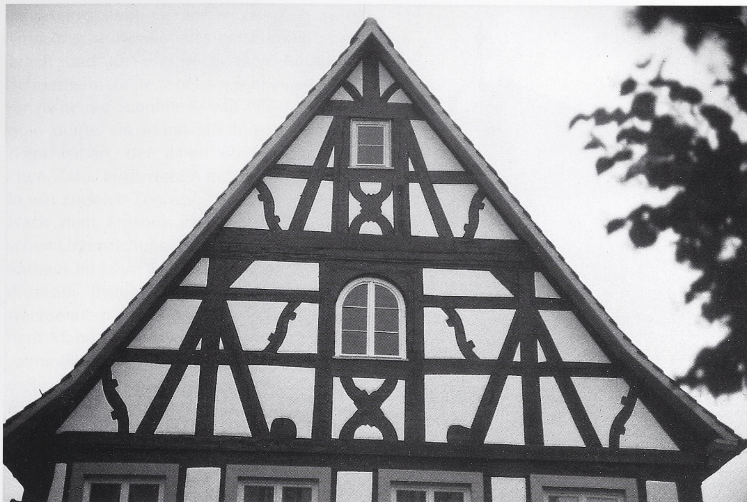
Abb. 14: Schriesheim, Rathaus. Der Fachwerkgiebel von Norden. Im Giebeldreieck ist noch ein verziertes Fachwerk mit „Mann“-Figur, Winkelhölzern und Dreiviertelstreben aus der Erbauungszeit 1682ff. vorhanden. In der ersten Dachgeschoßebene sind die Balkenköpfe der nachträglich eingezogenen Längsüberzüge zu erkennen.
