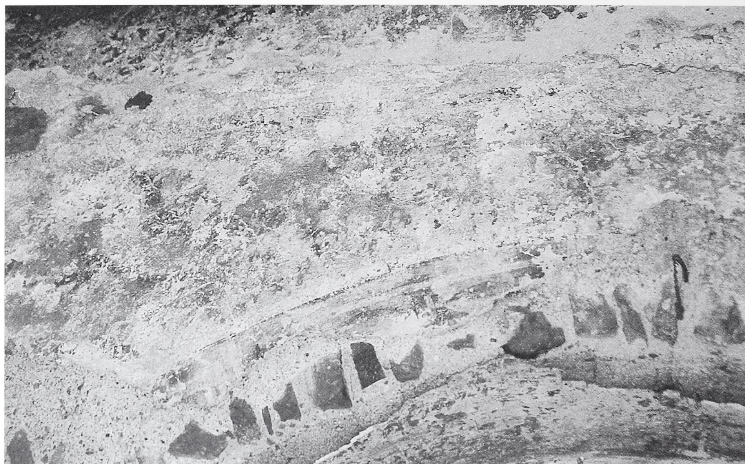
Abb. 5: Schriesheim, Rathaus. Detailaufnahme der historischen Bemalung über der östlichen Wandnische, die noch vom Vorgängerbau des Rathauses stammt.
