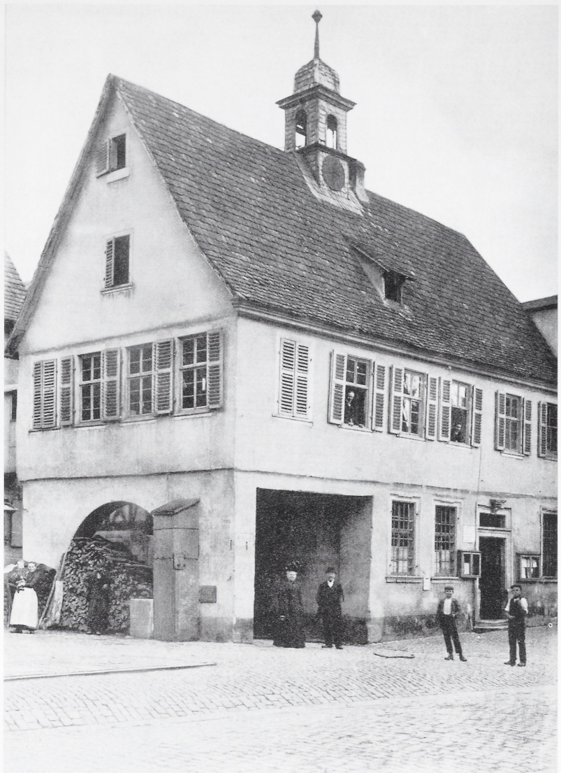
Abb. 17: Schriesheim, Rathaus um 1900. Bereits im Jahre 1791 erfolgte eine große Umbaumaßnahme, bei der die westliche Traufwand im Erdgeschoß durch eine Massivwand ersetzt wurde. Auch das Fachwerk erhielt einen flächigen Verputz und präsentierte sich somit als zeitgemäßer Barockbau, der vermutlich farbig gestaltet war.
