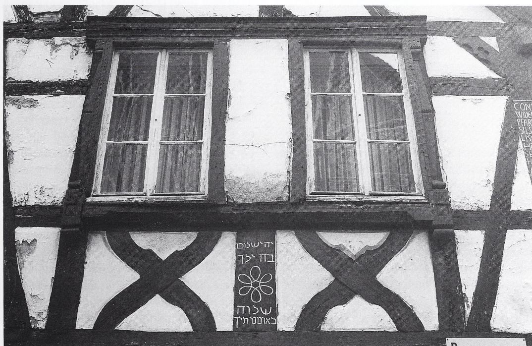
Abb. 15: Schriesheim, Rosengasse. Das Nachbargebäude des Rathauses kann als Vergleichsbeispiel für die Befensterung dienen. Hier ist noch ein ursprünglich verzierter Fenstererker aus dem Jahre 1662 vollständig erhalten. Das Fachwerk weist große Ähnlichkeit zum erbauungszeitlichen Fachwerk des Schriesheimer Rathauses auf.
