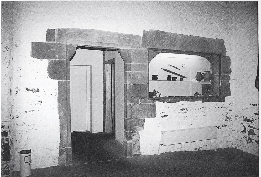
Abb. 15: Heimsheim, Steinhaus. Tür und stichbogiges Fenster zwischen Flur und ehemaliger Küche im Erdgeschoß. An beiden Öffnungen sind verzierte Werksteinkonsolen vorhanden.
