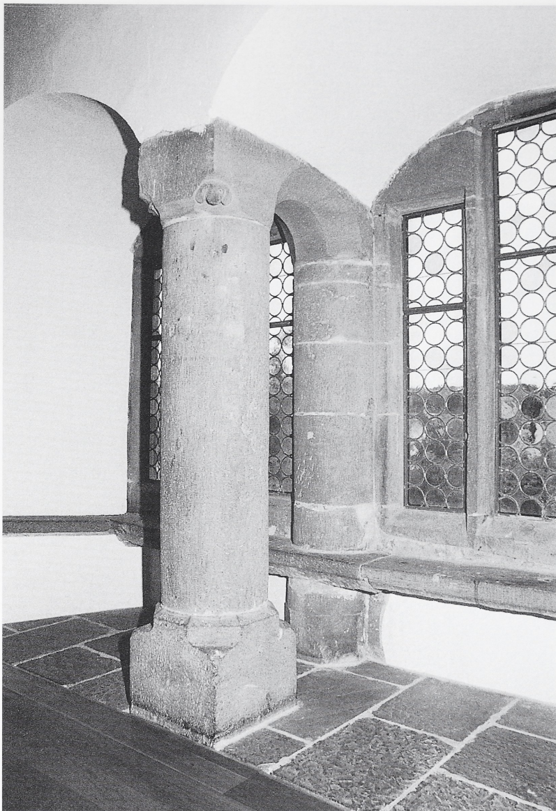
Abb. 19: Heimsheim, Steinhaus. Freisäule der Doppelfensteröffnung im ersten Obergeschoß. Ein kleines Hundeköpfchen bildet die Eckzier des Kapitells.
