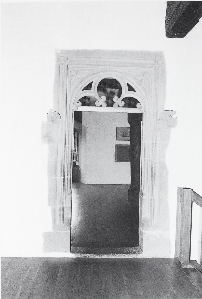
Abb. 18: Heimsheim, Steinhaus. Werksteingewände mit Maßwerkformen im ersten Obergeschoß zwischen Saal und südlicher Querzone.
