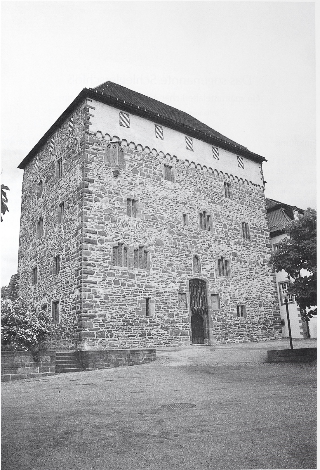
Abb. 1: Heimsheim, Steinhaus. Ansicht von Südosten.
