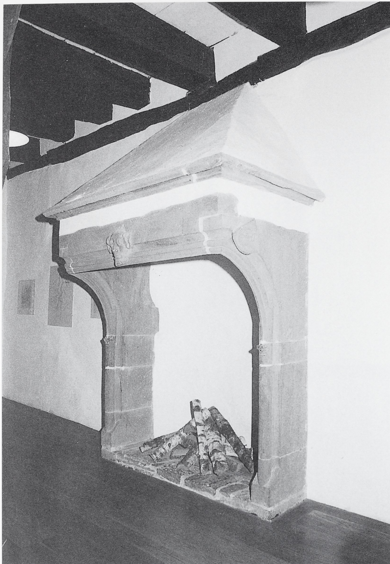
Abb. 20: Heimsheim, Steinhaus. Kamin von 1415 im Saal des ersten Obergeschosses.
