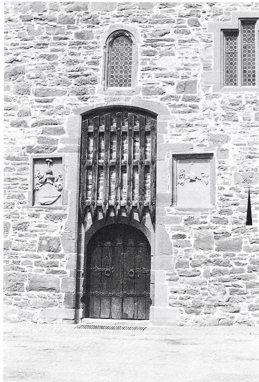
Abb. 7: Heimsheim, Steinhaus. Eingangsportal der Ostfassade mit Wappentafeln der Familien Selbach und Gemmingen von 1415. Das Fallgatter wurde im 20. Jahrhundert rekonstruiert. Die Türflügel stammen von 1574. Über dem Portal eine Rundbogenöffnung mit Maßwerkresten. Am rechten Bildrand der abgearbeitete Konsolstein eines ehemaligen Erkers (Pfeil).
