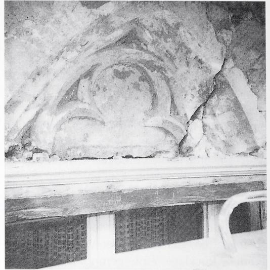
Abb. 7: Rottweil, Präsenzgasse 5. Die erhaltenen Bruchstücke der Blendbögen aus Stuckmörtel.
