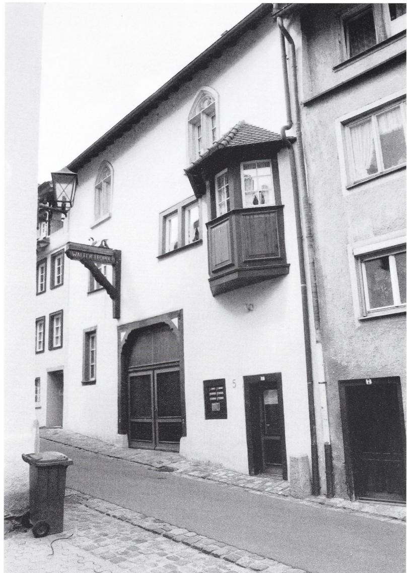
Abb. 5: Rottweil, Präsensgasse 5. Ansicht des Gebäudes von Südosten. Im zweiten Obergeschoß sitzen zwei Doppelfenster mit aufgesetzten Blendbögen. Die bei Sanierungsarbeiten aufgefundenen Reste der Blendbögen aus Stuckmörtel wurden in Sandstein ersetzt und die zugehörigen Fensteröffnungen ergänzt.
