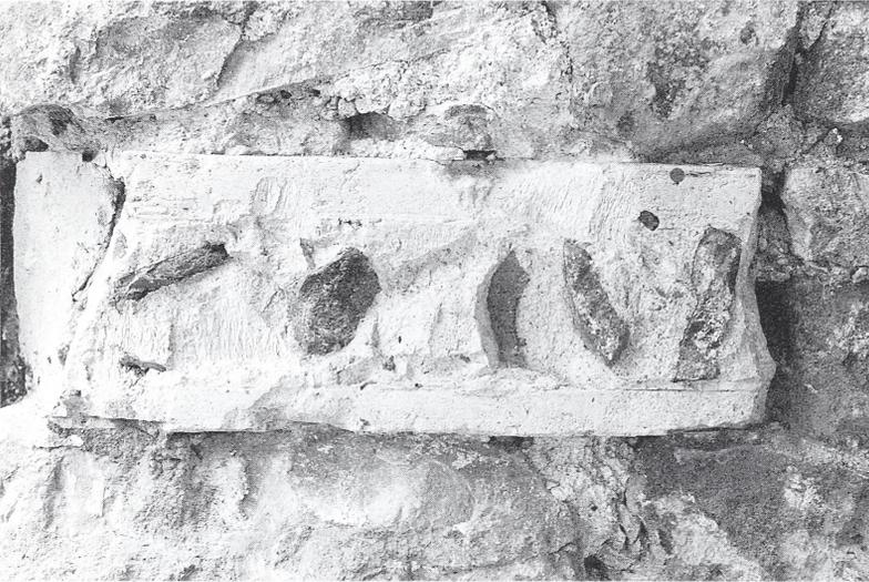
Abb. 22: Rottweil, Hochturm-gasse 4. Zwei eingemauerte Bruchstücke aus Stuckmörtel vom ehemaligen Mittelpfosten einer mehrteiligen Fensteröffnung. Oben die Vorderseite des ursprünglich unteren Teils mit auslaufenden Fasen und Ritzlinien zu deren Ausarbeitung, unten die Rückseite des ursprünglich oberen Teils mit abgespitztem Steg zwischen zwei Fälzen und darin eingebetteten Bruchstücken von Hohlziegeln.
