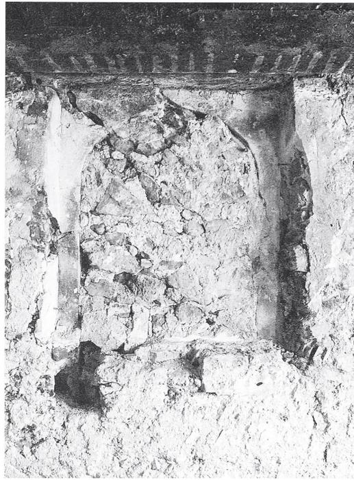
Abb. 19: Rottweil, Hochturmstraße 12. Vermauerte rundbogige Türöffnung mit Stuckmörtellaibung und einer wenig breiteren Nische davor, die von einem Sturzholz abgedeckt wird, aufgenommen vom Inneren des Gebäudes. Rechts ist ein eingemauertes und eingeputztes Holz zu erkennen, das vermutlich dem Verschließen der Öffnung diente.
