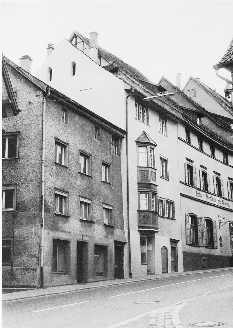
Abb. 1: Rottweil, Hauptstraße 62. Ansicht des Gebäudes von Nordosten. Im Giebeldreieck erkennbar zwei spitzbogige Fensteröffnungen mit Stuckmörtellaibungen.
