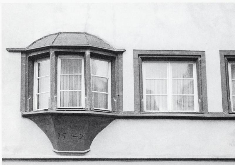
Abb. 34: Rottweil. Konsolerker und Fenstergewände des 16. Jahrhunderts aus Buntsandstein. Oben Hauptstraße 48, sogenanntes Herenkramer'sches Haus, 1629 aufgestockt; unten Hauptstraße 22, ehemaliges Kanzleibäude, 1547.
