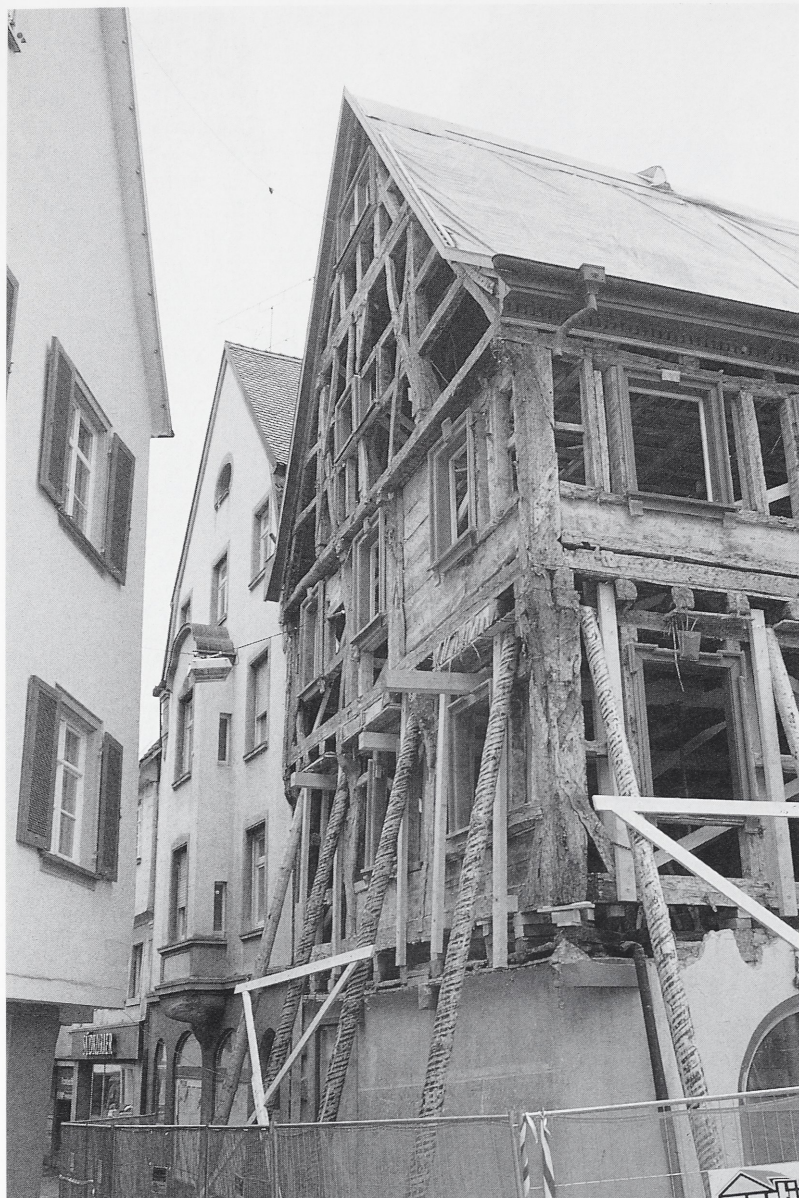
Abb. 4: Meßkirch, Hauptstraße 27. Blick auf die östliche Giebelseite im entkernten Zustand. Gut zu erkennen sind die Reste der Bohlenstube im ersten Obergeschoß mit erhaltener Verbohlung der Brüstungszone und Brustriegel des ehemaligen Fensterbandes.
