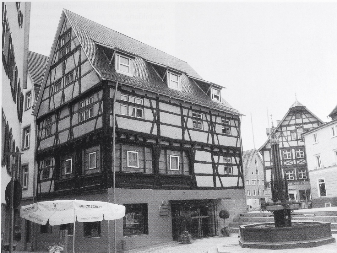
Abb. 3: Meßkirch, Hauptstraße 27. Blick auf die Vordertraufe nach Abschluß der Sanierung mit wiederhergestelltem spätmittelalterlichen Fachwerk und modernen Attributen.
