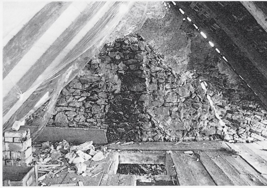
Abb. 7: Villingen, Brunnenstraße 34. Westlicher Giebel von innen gesehen. Ausschnitt Dachspitz. Auf dem Giebel von 1317/18d sitzt die Aufmauerung von 1322/23d. Die verbleibende Aufmauerung erfolgte um 1832.
