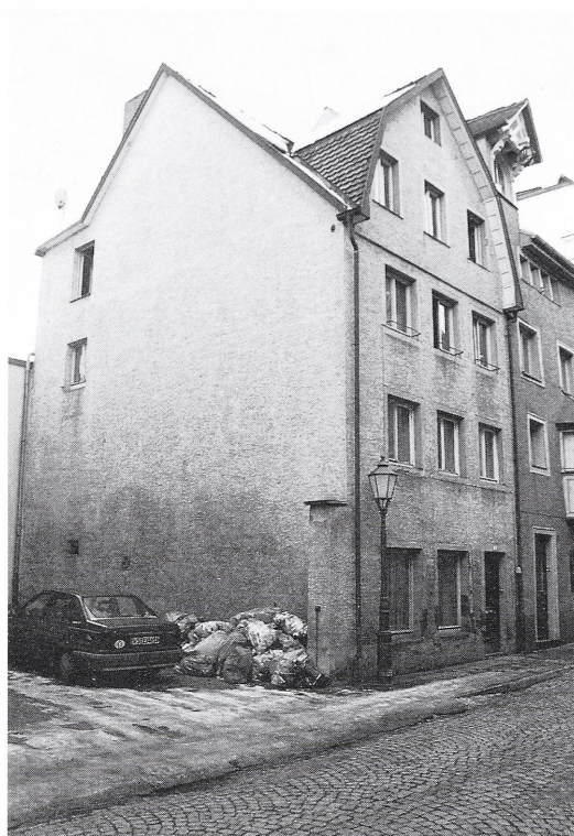
Abb. 18: Villingen, Hans-Kraut-Gasse 4, Ostgiebel. Auffällig die spärliche Durchfensterung zur Baulücke.
