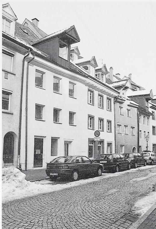
Abb. 2: Villingen, Brunnenstraße. Straßenansicht der Gebäude Nr. 32, 34 und 36 (von rechts nach links).
