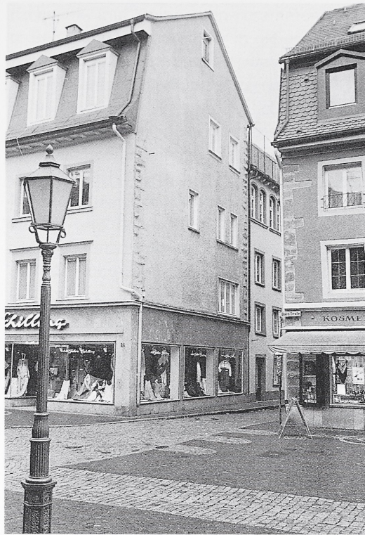
Abb. 27: Villingen, Obere Straße 26. Die in unterschiedlichen Höhen resultierenden Buckelquaderecken resultieren aus einer ehemaligen Pultdachausführung und sind nicht als Hinweis auf eine ehemals höhere Baustruktur zu interpretieren.
