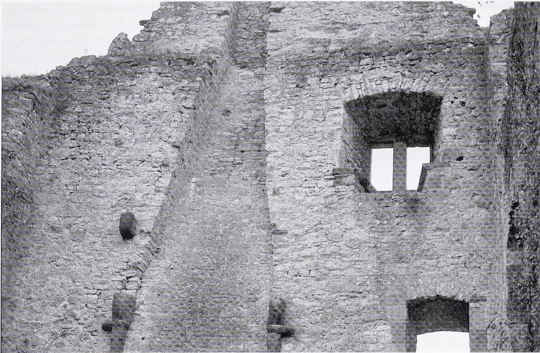
Abb. 5: Landeck, Obere Burg. Innenseite der Ostwand des Palas. An der Rückwand des Kamins, auf Höhe des Fensters, deutet ein senkrechter Riß eine vermauerte Öffnung an.
