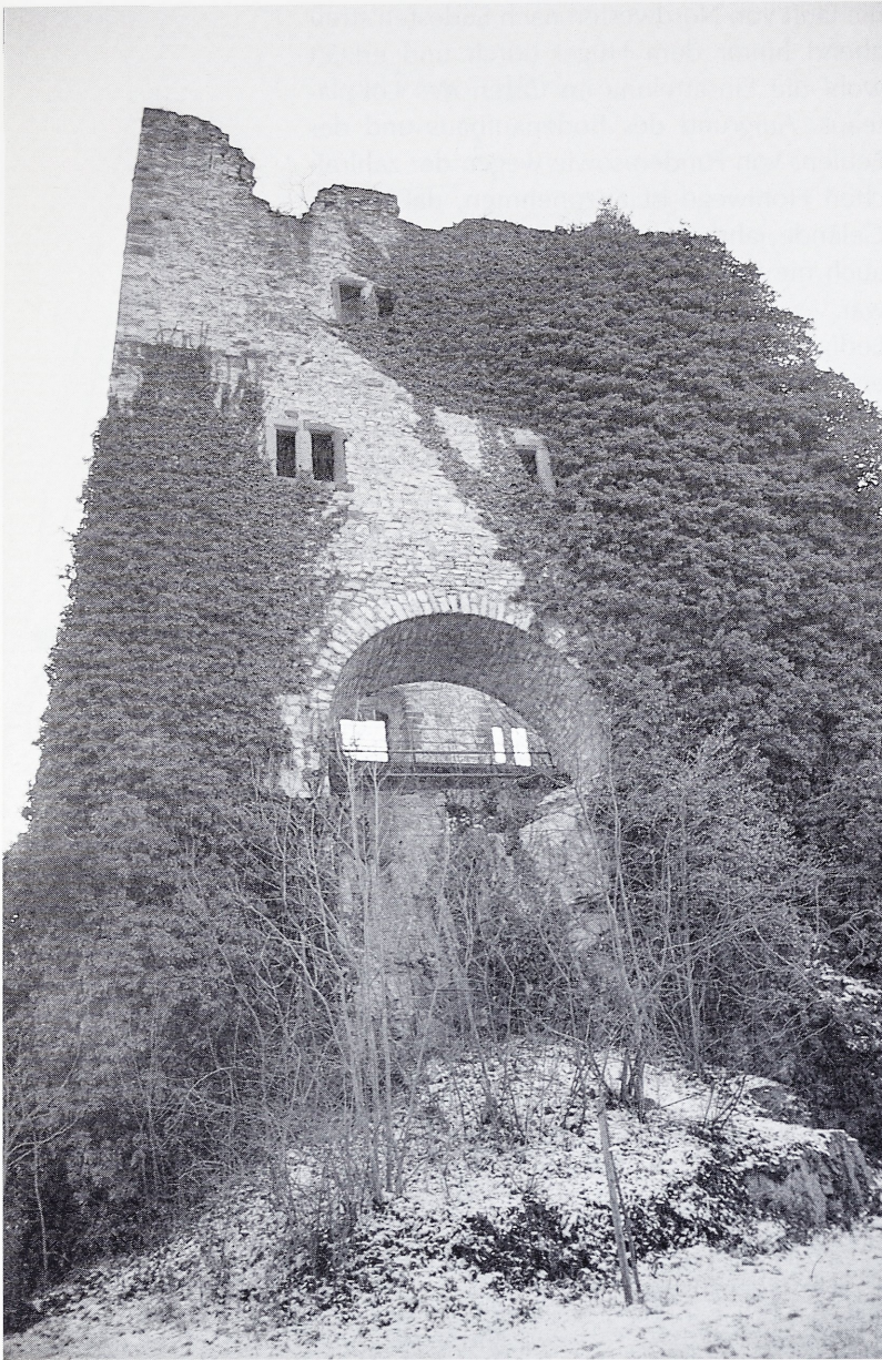
Abb. 4: Landeck, Obere Burg. Nördliche Außenwand des Palas mit einem Spannbogen.
