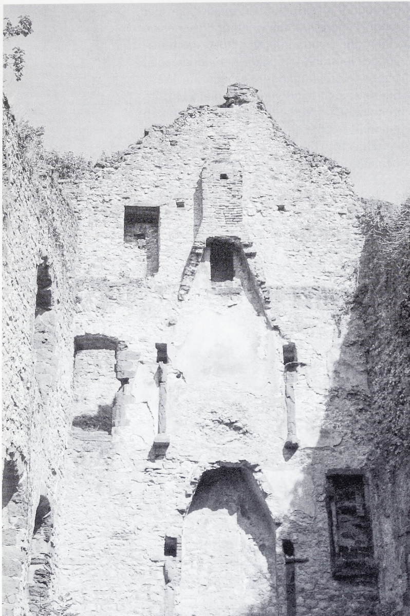
Abb. 9: Landeck, Untere Burg. Nördliche Giebelwand des Palas mit Kaminen und vermauerten Türen.
