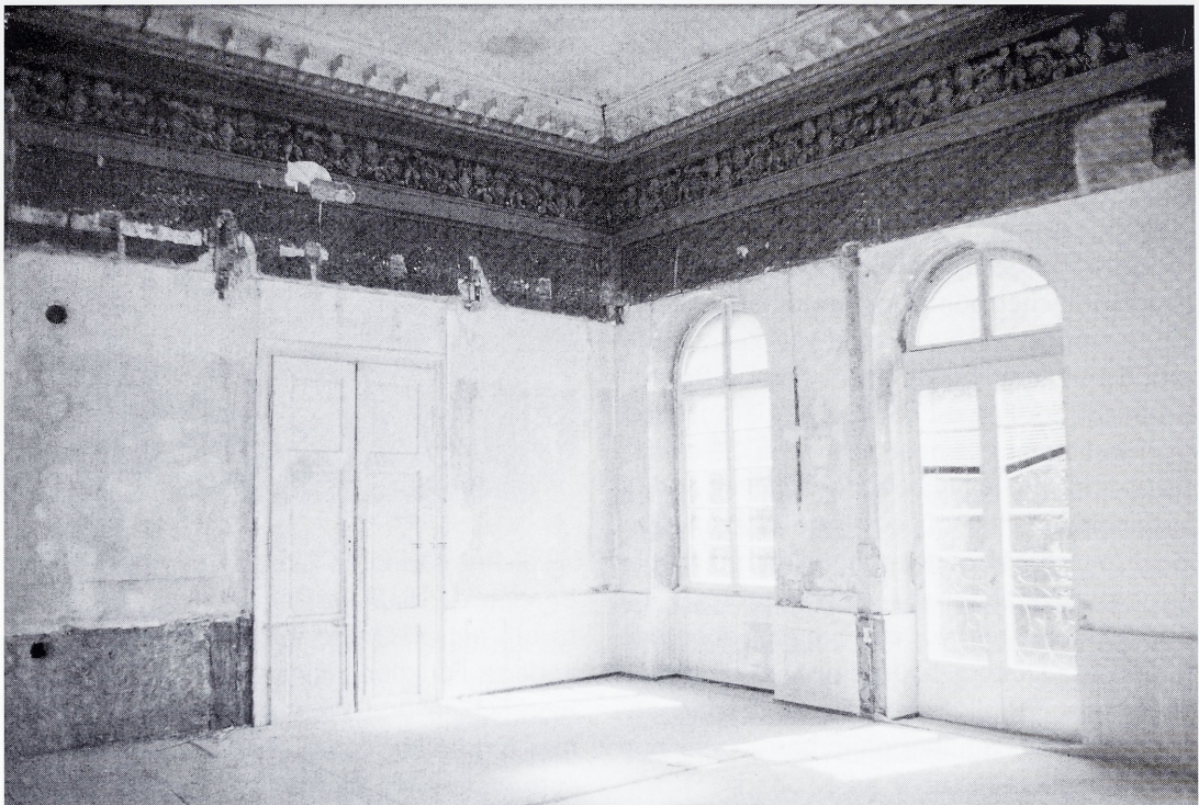
Abb. 9: Ettlingen, Villa Watthalden. Saal im Obergeschoß nach Entfernung der Zwischendecke, 1997.
