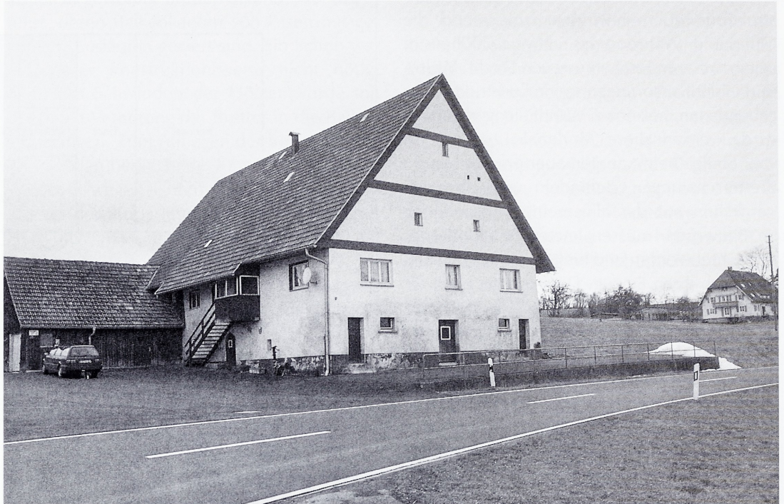
Abb. 18: Schramberg-Sulgen, Deisenhof. Aktuelle Aufnahme mit vollflächig verputzten Außenwänden.
