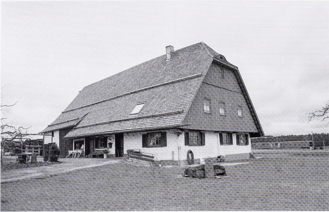
Abb. 24: Aichhalden, Reißenhof. Aufnahme des derzeitigen Zustands mit verputztem Unterbau, bretterverschaltm Giebel und neuer Schindeldeckung.
