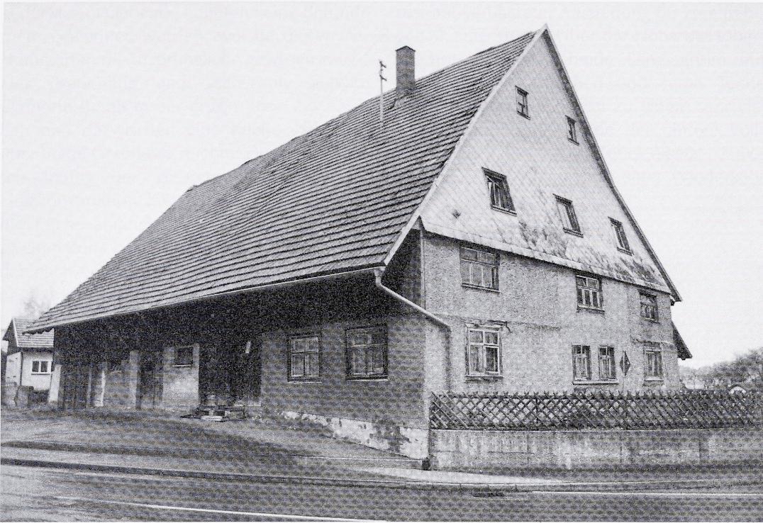
Abb. 12: Eschbronn-Mariazell, Lazershof. Aufnahme des jüngsten Zustands mit vorgeschobener, verputzter Giebelwand und verschalteten Außenwandflächen.
