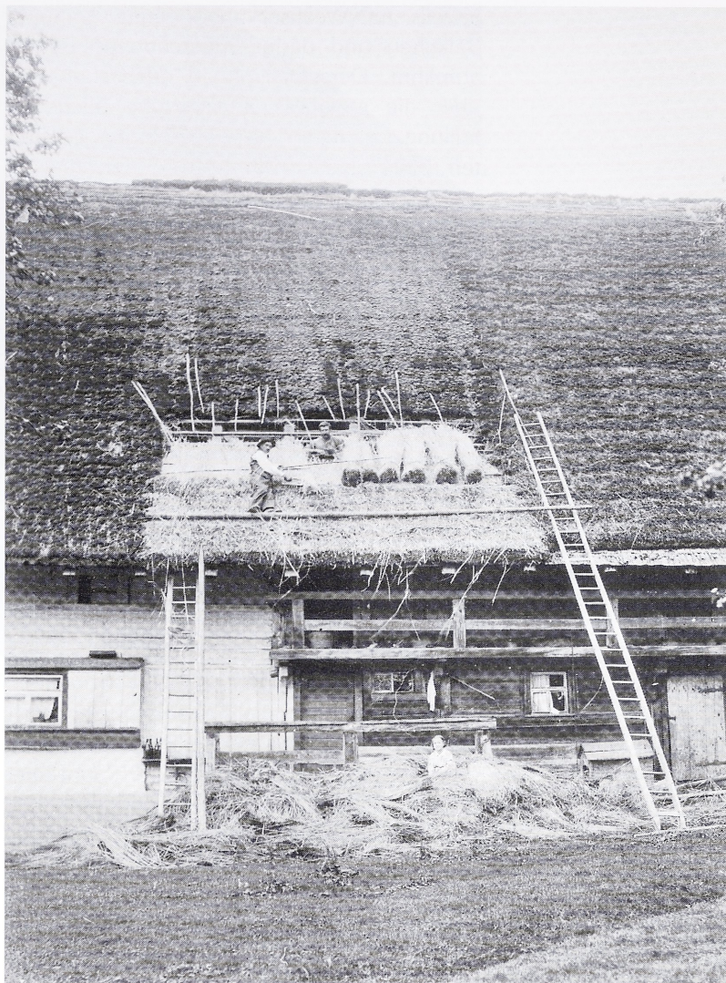
Abb. 8: Schramberg-Sulgen, Specksepplehof. Aufnahme vom Ausbessern des Strohdachs von Max Lohss, um 1929. Im abgeworfenen Stroh sitzt eine Tochter von Lohss.
