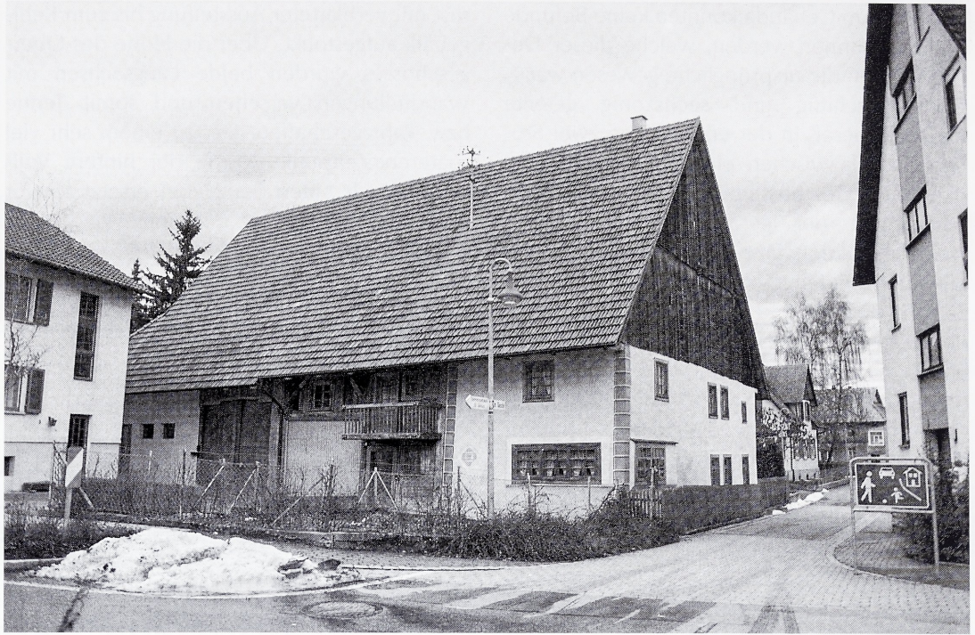
Abb. 15: Villingendorf, Oberndorfer Straße 5. Aufnahme nach der Restaurierung des Gebäudes mit Fenstererker, restaurierter Kantenquaderung und originaler Bretterschalung im Giebeldreieck.
