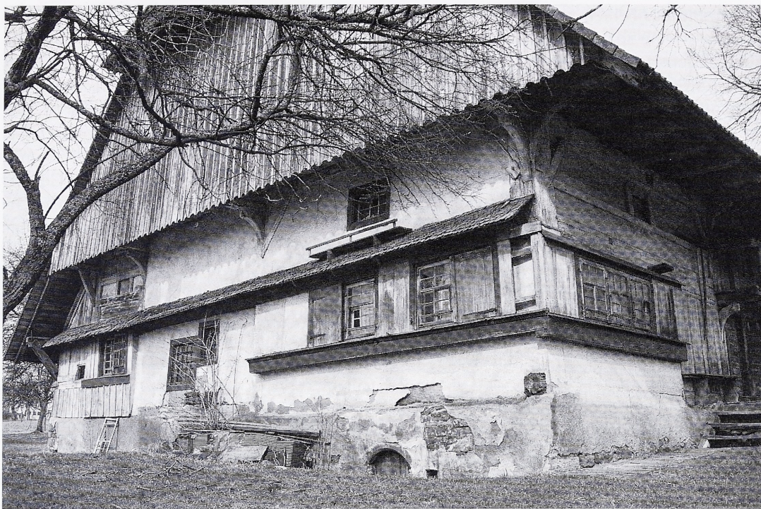
Abb. 9: Schramberg-Sulgen, Specksepplehof. Aufnahme des Vorgiebels mit verputzter und verschaltes Holzkonstruktion, schmalem Vordach und vorkragendem Giebel; vorne die Stube mit Fenstererker, ganz rechts schaut der Schub der Bohlendecke aus der Wandflucht hervor, darüber ein kleines Kammerfenster, unten der Kellerzugang.
