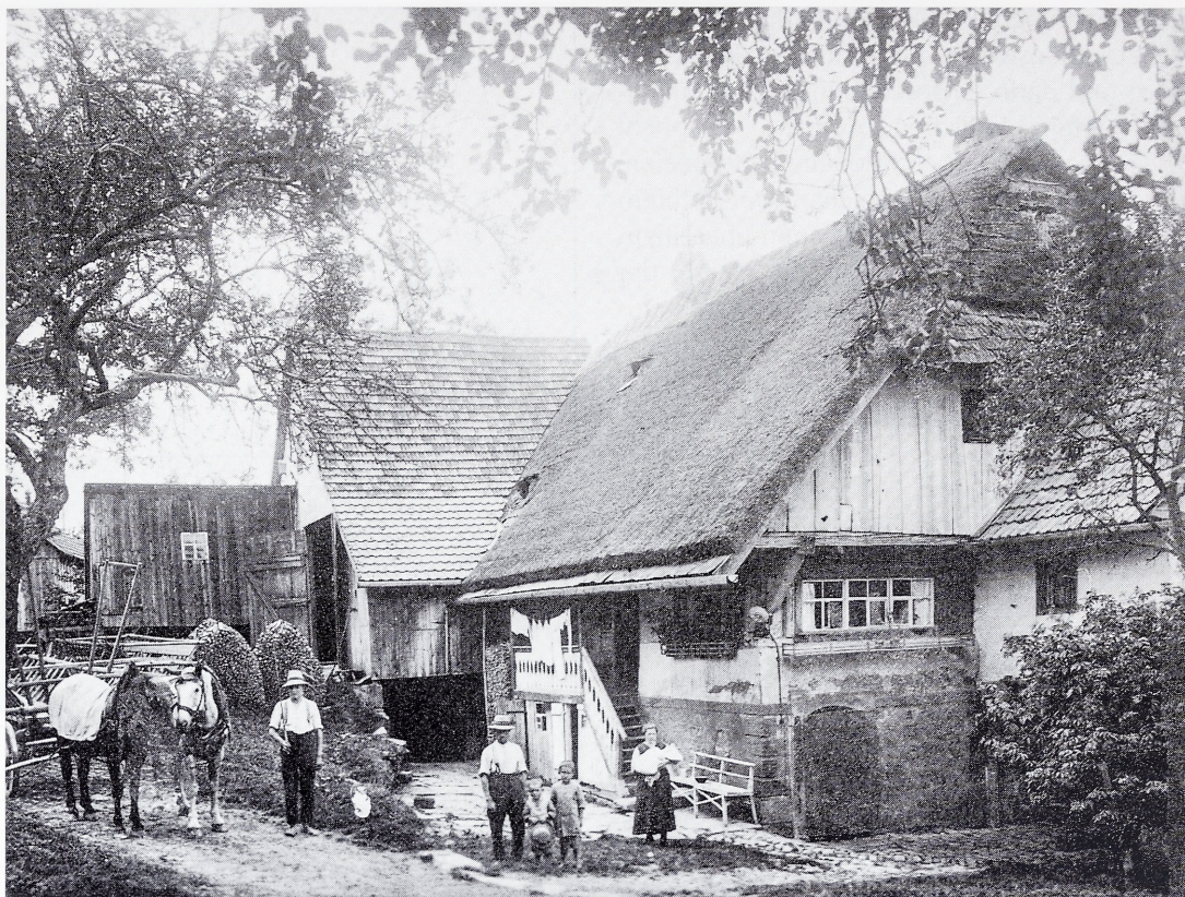
Abb. 27: Dunningen-Giffizenmoos, Haus Seckinger. Aufnahme um 1925 mit Strohdach, seitlicher Hocheinfahrt und verschiedenen Anbauten.
