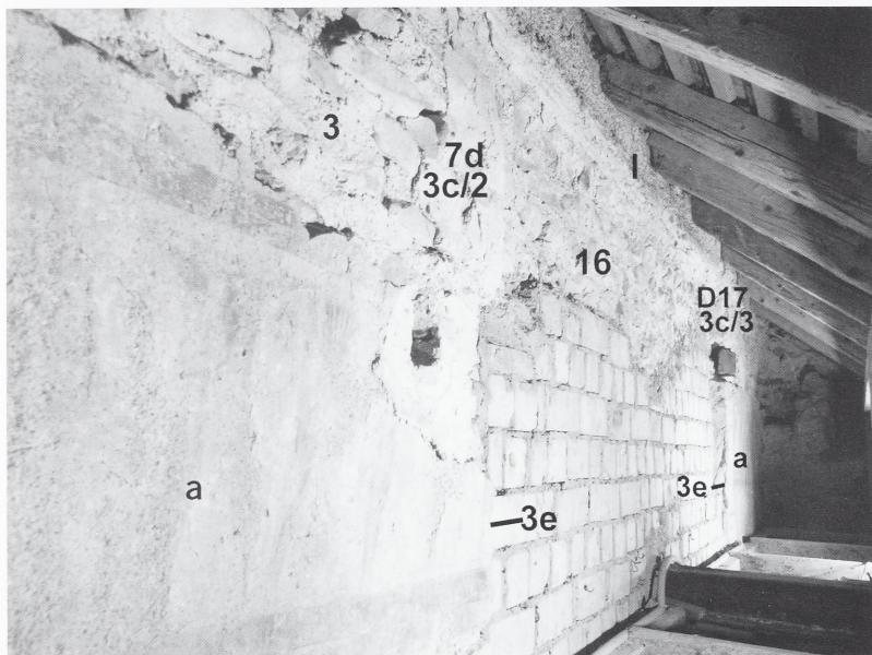
Abb. 43 (oben): Nördlicher Dachraum. Arkaden- und Obergadenmauer des Mittelschiffes. Von Nordosten. Anfängersteine des weiten Konchenbogens und -gewölbes (2d, 2j, 2n) an der westlichen Laibung der Konche, aus der ersten Etappe der Basilika. Negativ des Lehrgerüstes (2e) des Konchenbogens/-gewölbes. Obergadenmauer (3a) und Mauer (3) des engen Konchenbogens der zweiten Etappe der Basilika. Negativ des Decken-/Bundbalkens (3c/4) zur Basilika-Konche der zweiten Etappe.
