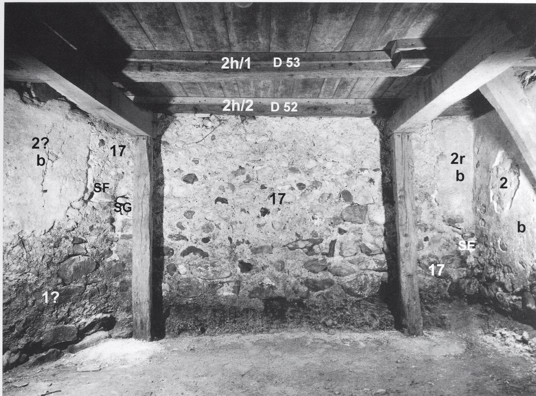
Abb. 52: Südlicher Keller. Westmauer. Von Osten. Konche des Zentralbaus (1?). Spannmauer (2) des Konchenbogens und Konche (2?) der ersten Etappe der Basilika. Versatz (2r) auf der Flucht der in die Konche gestellten Mauer (17). Alter Verputz (b). Decken-/Bodenbalken (2h/1, 2h/2).
