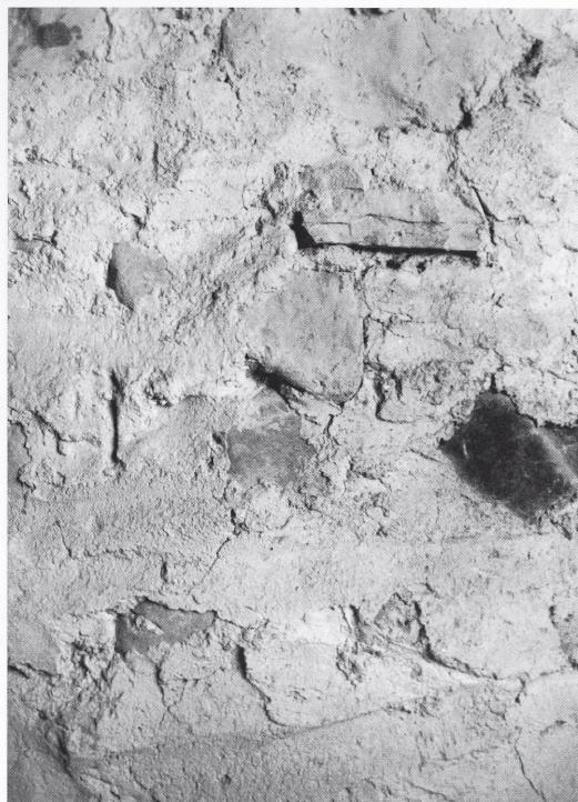
Abb. 65: Südlicher Dachraum. Rücken der Konche. Mauerwerk (2) der ersten Etappe der Basilika.
