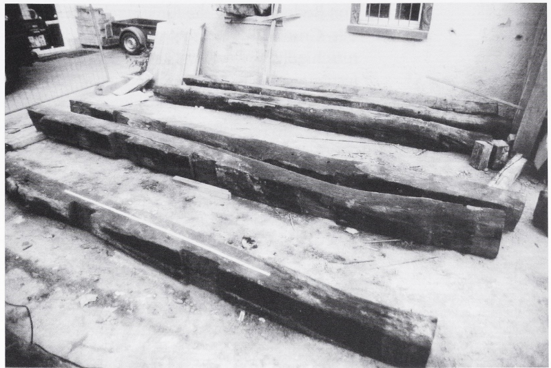
Abb. 10: Reutlingen, Kanzleistraße 24. Ausgebaute Deckenbalken über dem EG von 1267 (d) während der Befundaufnahme.
