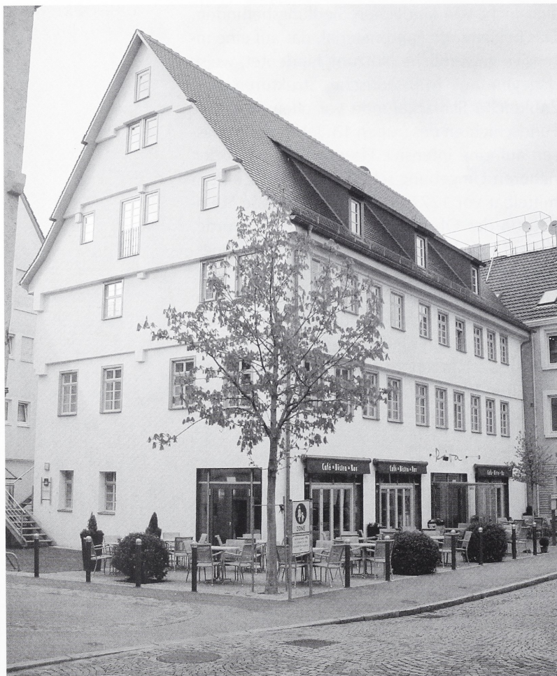
Abb. 2: Reutlingen, Kanzleistraße 24. Das Gebäude von Südwest im April 2004.
