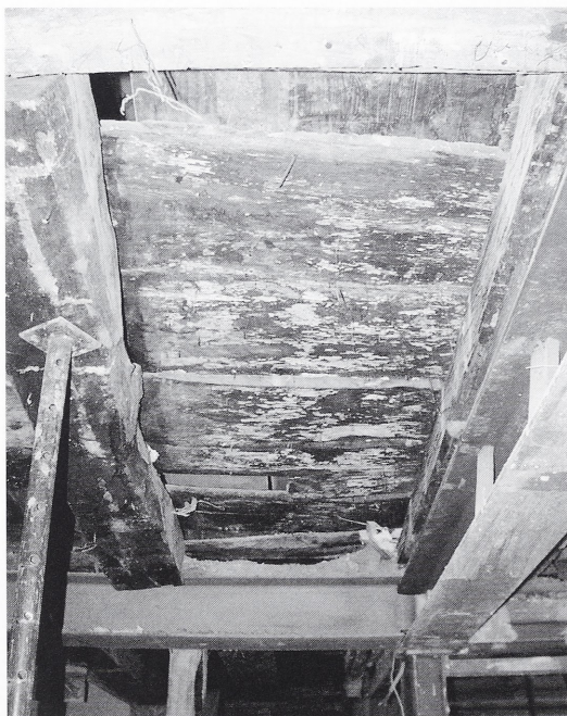
Abb. 9: Reutlingen, Kanzleistraße 24. Überreste des vermutlich bauzeitlichen Dielenbodens über dem Erdgeschoss (1999).
