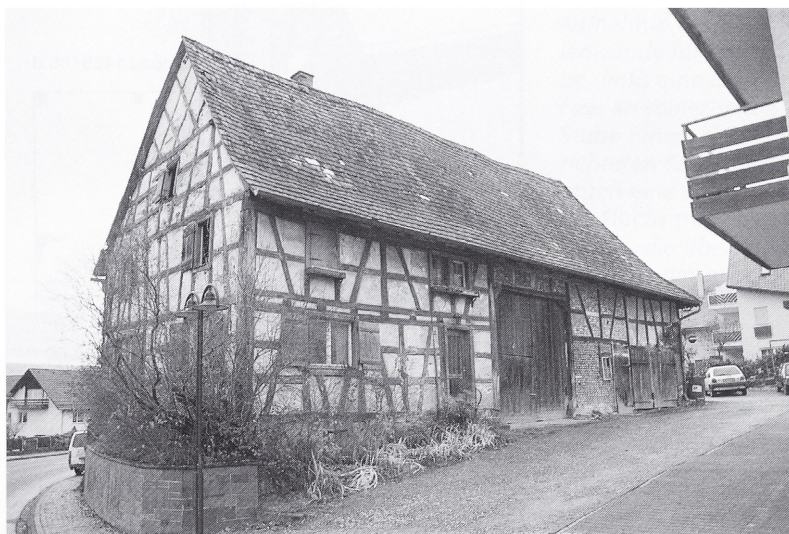
Abb. 4: Horn, Hauptstraße Nr. 122. Der auf der linken Seite liegende Wohnteil umfasste den um 1486 errichteten Kernbau, von dem bei näherem Hinsehen noch einige der über beide Geschosse reichenden Ständer und Verblattungen im Fachwerk zu erkennen waren.
