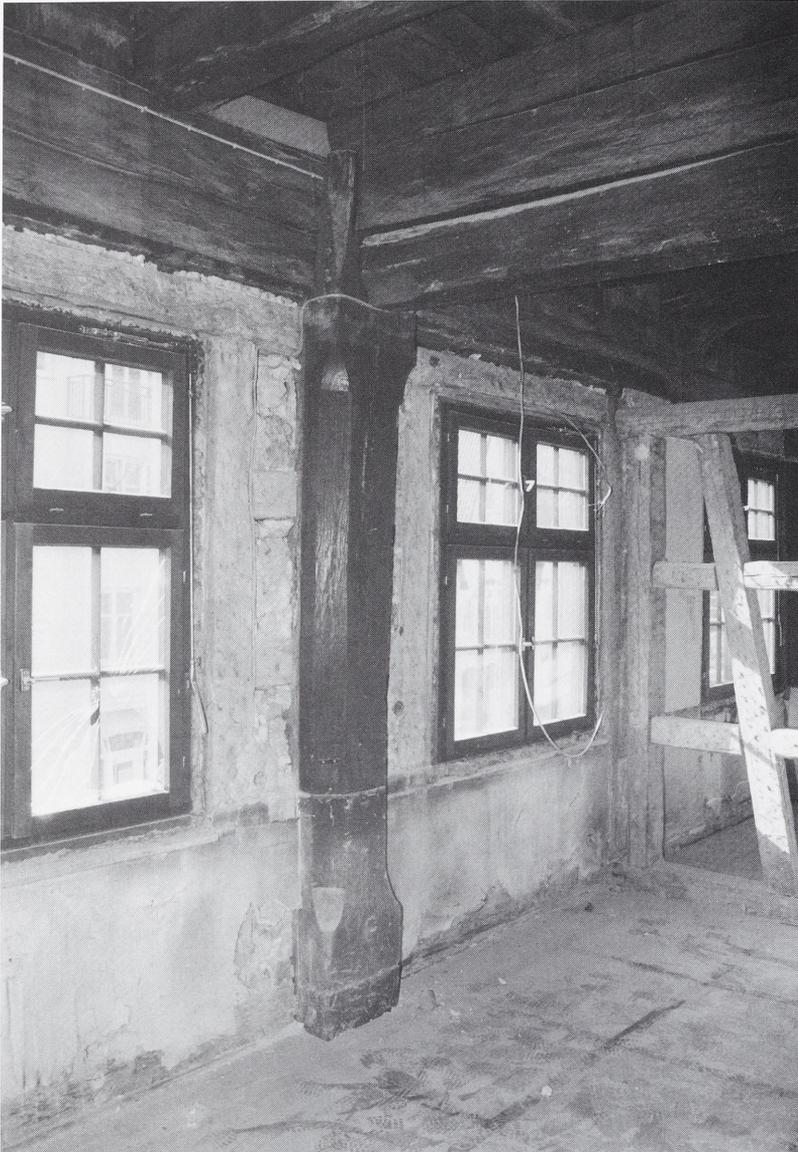
Abb. 5: Veringenstadt, Rathaus. Mittelalterlicher Mittelständer in der südlichen Giebelscheibe des 1. Obergeschosses. Rechts und links an den Ständer schlossen ursprünglich über die ganze Fassadenlänge durchlaufende Fensterbänder an.
