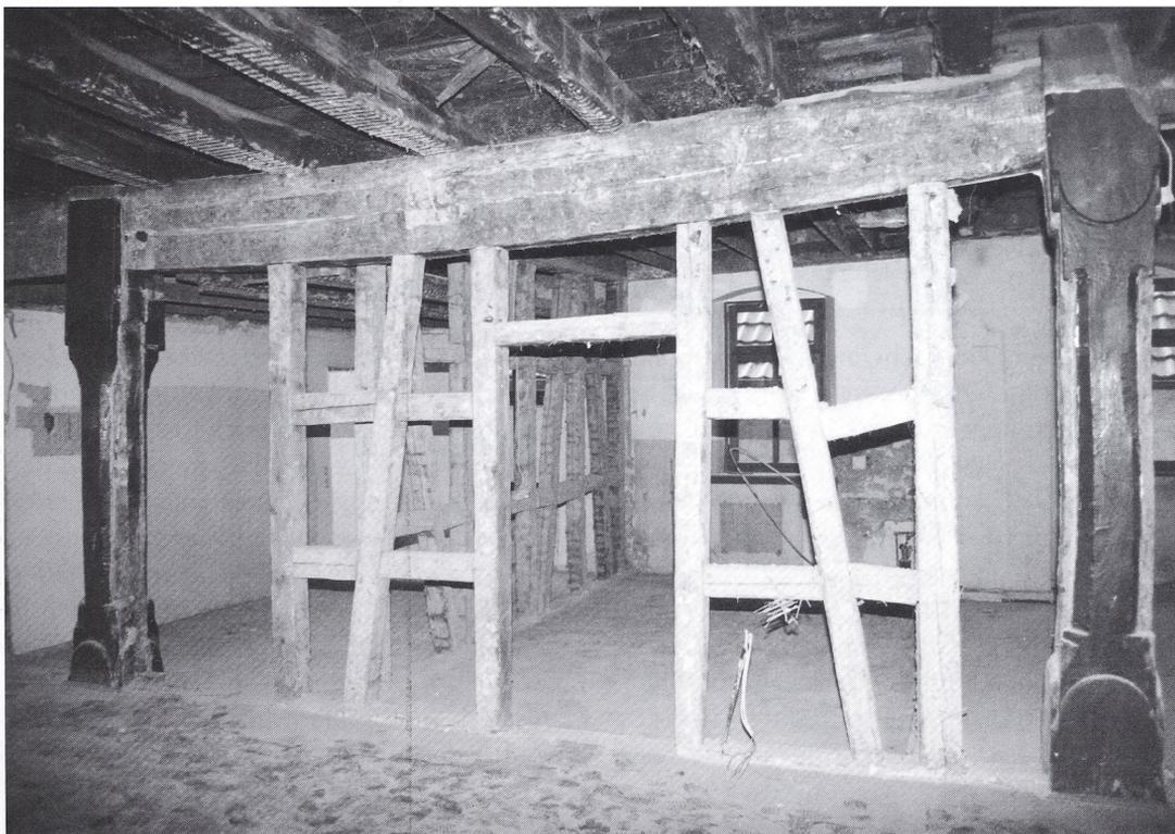
Abb. 4: Veringenstadt, Rathaus. Blick in das Innere des 1. Obergeschosses während der Renovierungsarbeiten. Die mittelalterliche Konstruktion mit den zwei kräftigen Tragsäulen, dem doppelten Unterzug und dem Deckengebälk liegt offen.
